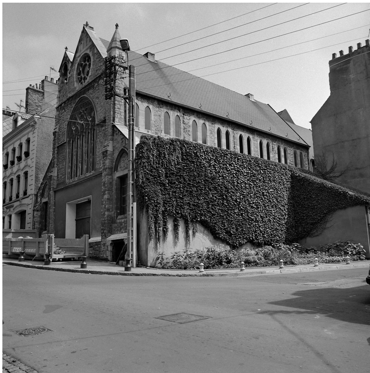
Vue d'angle ouest sur voie.
