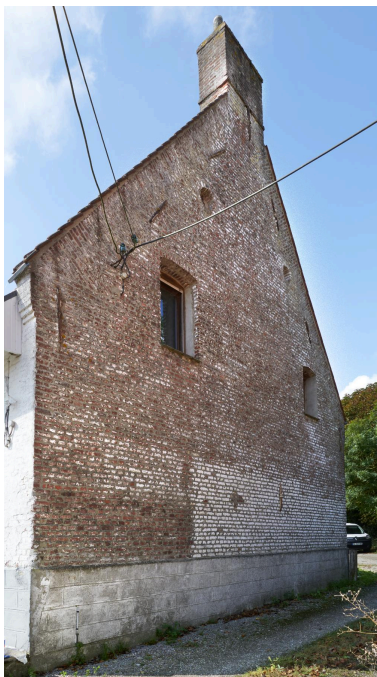
Pignon nord-est du logis de la ferme. Phot. Delphine Volto Jourdan IVR32_20245903136NUCA
