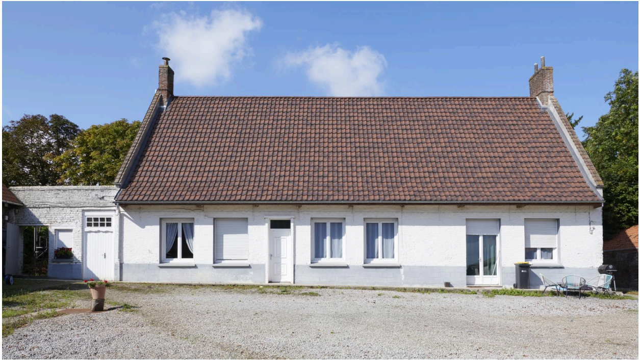
Façade sur cour du logis de la ferme.
