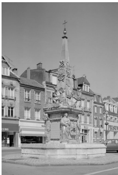
Vue éloignée. Phot. Fabrice Charrondière IVR22_19856001258X
