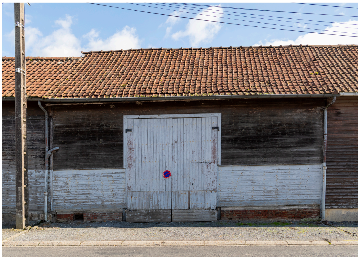
Grange en pans de bois essentée de planches, n°21 de la rue Fernand-Moreau, vue depuis le nord.
