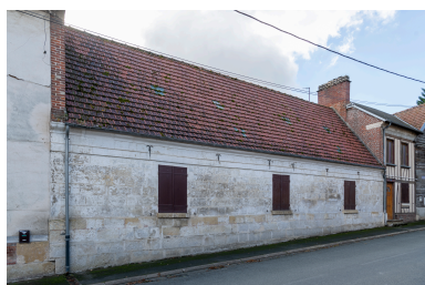
Logis en pierre, n°4 de la rue d'En-Bas, vue depuis le nord. Phot. Marc Kérignard IVR32_20246000924NUCA
