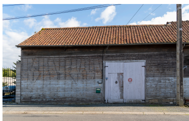
Grange essentée de planches, n°19 de la rue Fernand-Moreau, vue depuis le nord. Phot. Marc Kérignard IVR32_20246000932NUCA
