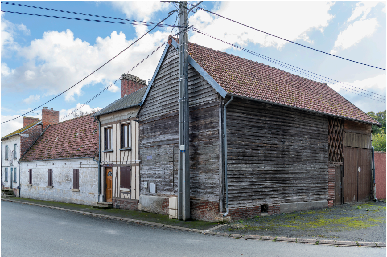
Vue depuis le nord de la rue d'En-Bas (n°2 à 4).
