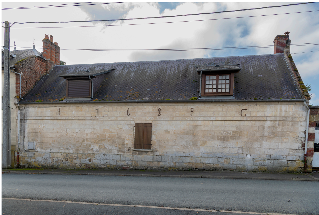
Maison en pierre datée de 1768, n°10 de la rue d'En-Bas, vue depuis le nord.
