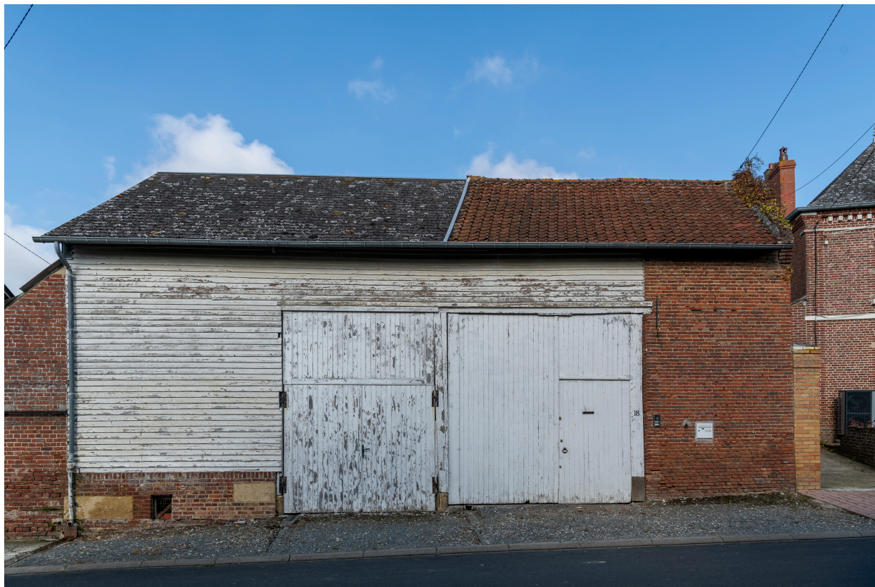
Grange essentée de planches, n°18 de la rue Fernand-Moreau, vue depuis le sud.
