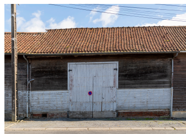
Grange en pans de bois essentée de planches, n°21 de la rue Fernand-Moreau, vue depuis le nord. Phot. Marc Kérignard IVR32_20246000933NUCA
