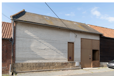
Grange essentée de planches avec porte à engranger, n°12 de la rue Fernand-Moreau, vue depuis le sud. Phot. Marc Kérignard IVR32_20246000928NUCA
