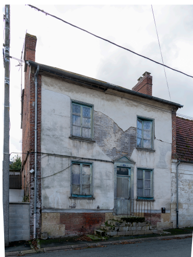
Logis en pans de bois et torchis, solins en pierre dure, n°4 de la rue d'En-Bas, vue depuis le nord. Phot. Marc Kérignard IVR32_20246000923NUCA
