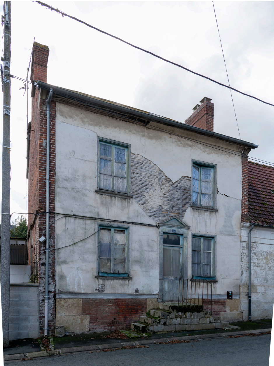
Logis en pans de bois et torchis, solins en pierre dure, n°4 de la rue d'En-Bas, vue depuis le nord.
