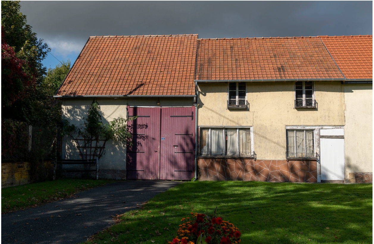
Entrée charretière et atelier sur la rue au n°1 de la rue du Cul-de-Sac, vue depuis le sud.
