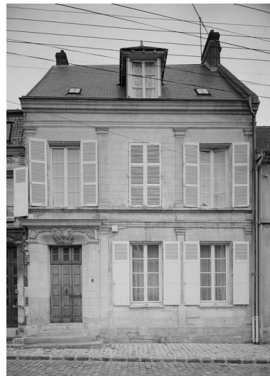
Élévation sur rue. Phot. Fabrice Charrondière IVR22_19856001418V
