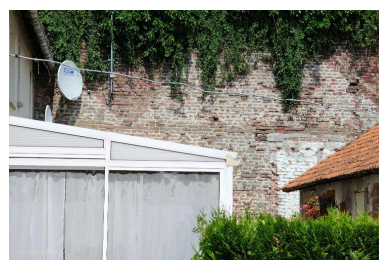
Traces d'une ancienne toiture en shed sur le mur en brique en fond de parcelle. Phot. Thierry Lefébure IVR22_20128000295NUC2A
