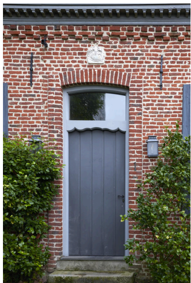
Détail de la porte d'entrée et du blason buché. Phot. Delphine Volto Jourdan IVR32_20255900397NUCA
