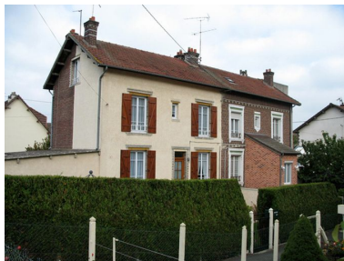
Une maison ouvrière, regroupant 4 logements, construite par les architectes Perret pour la société Marinoni. Phot. Clarisse Lorieux IVR22_20076005589NUCA
