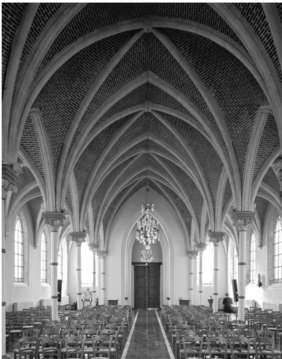
Vue générale intérieure vers l'entrée.
