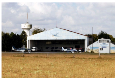
Vue du hangar. Phot. Thierry Lefébure
