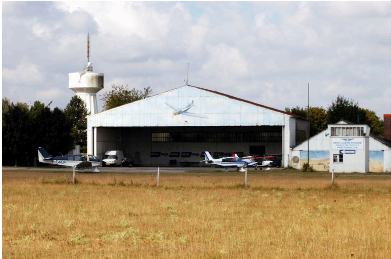
Vue du hangar.
