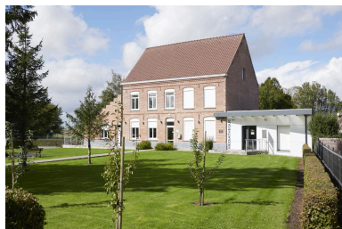
Vue de la façade depuis le nord. Phot. Delphine Volto Jourdan IVR32_20245903282NUCA
