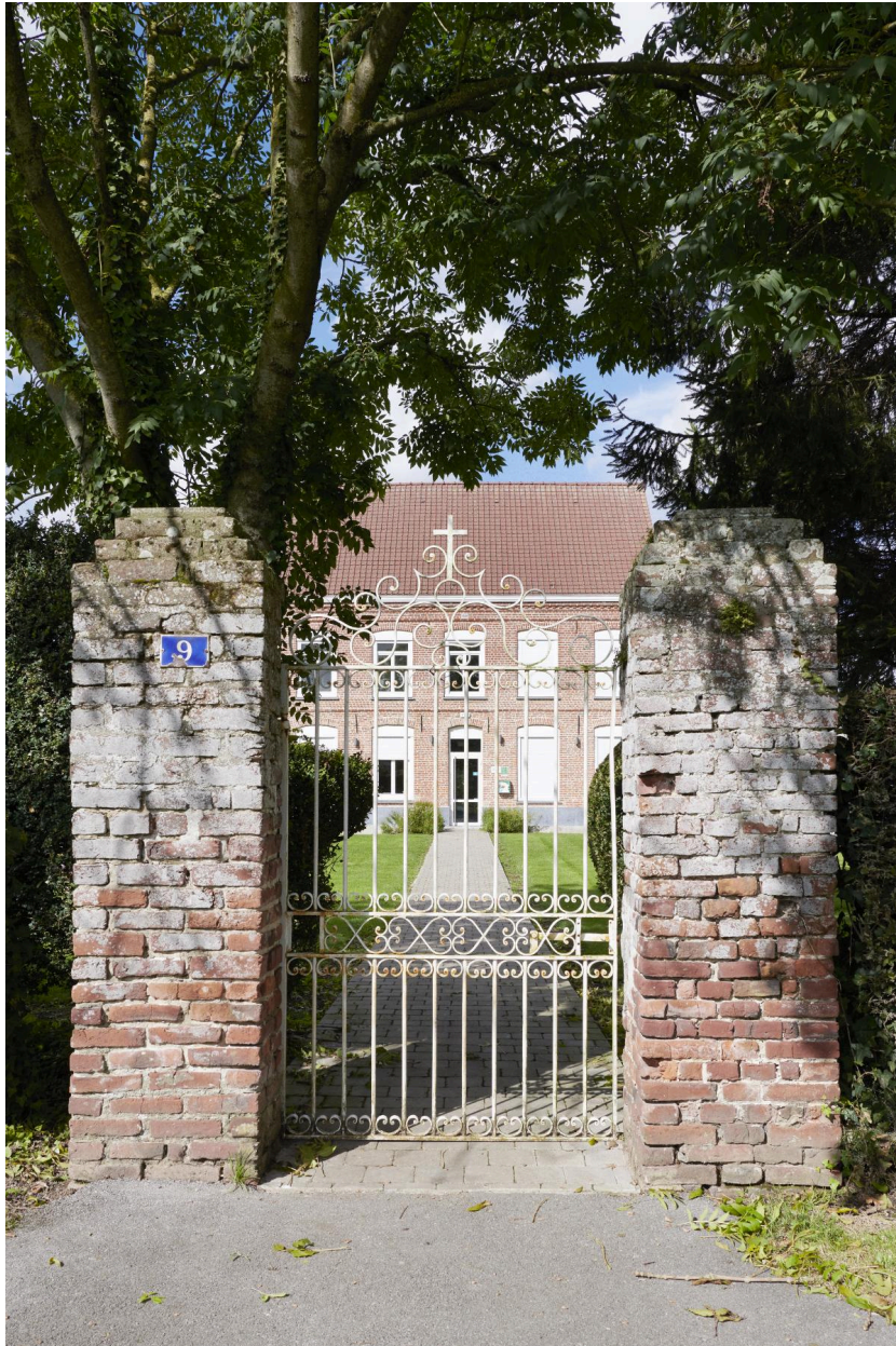
Portail d'entrée du presbytère.
