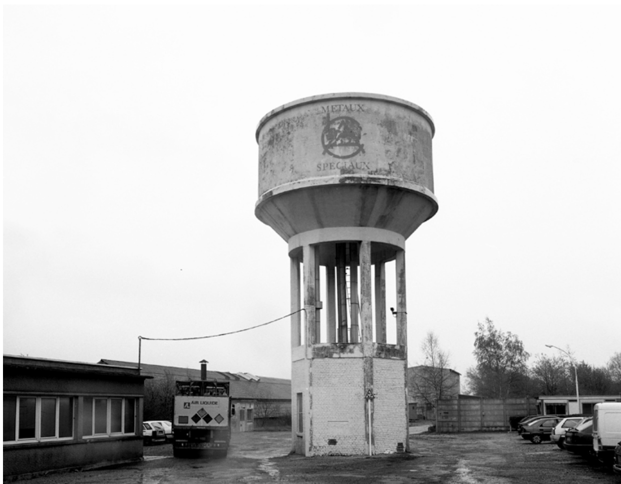
Le château d'eau.
