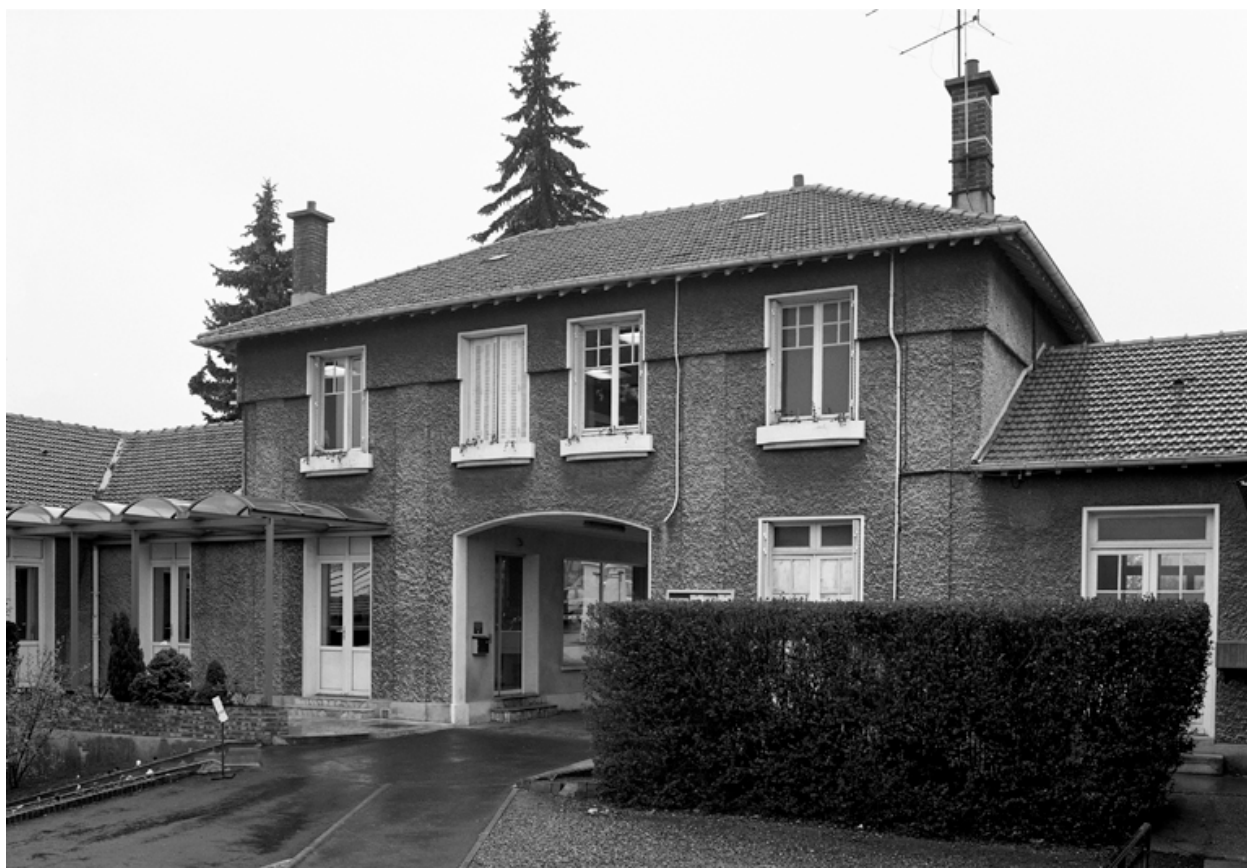
Les bureaux, façade est.
