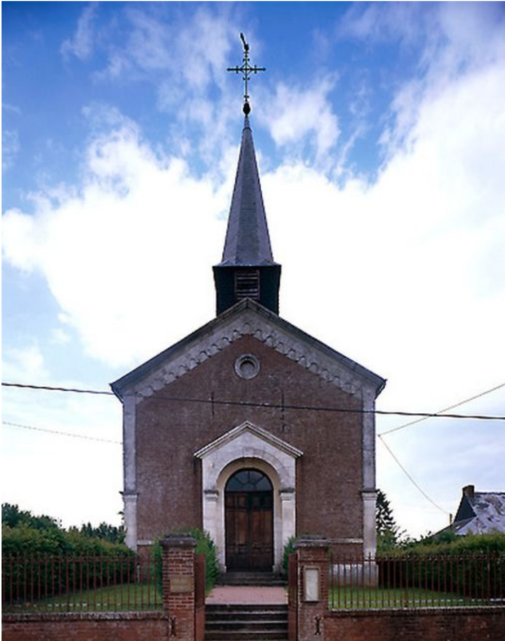
Vue générale de la façade occidentale.
