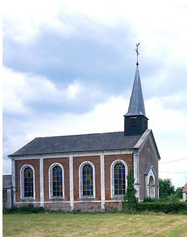
Vue générale. Phot. Franck Bürjes IVR22_19990202816VA
