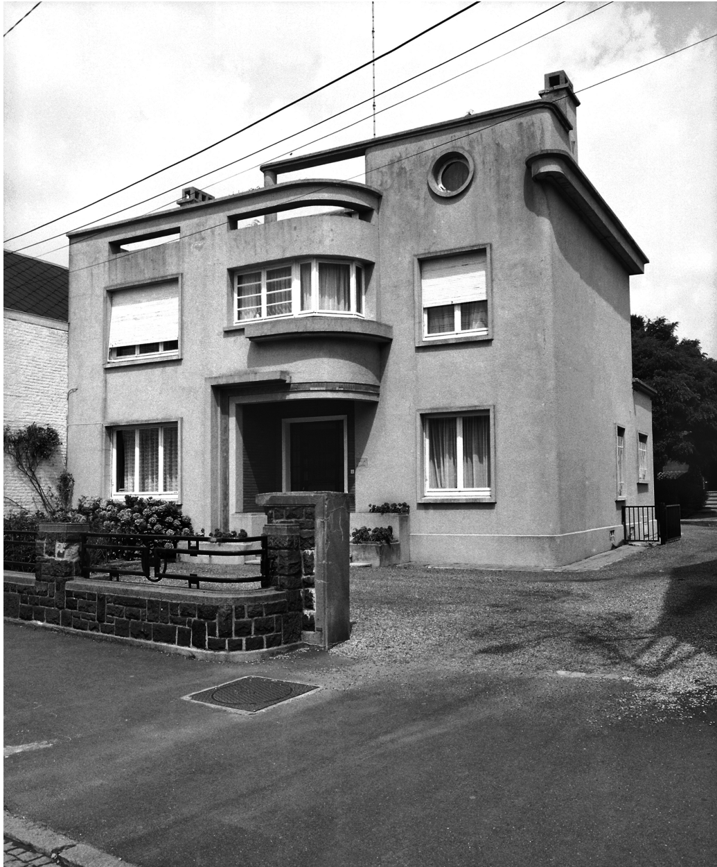
Vue générale de la maison, après sablage.
