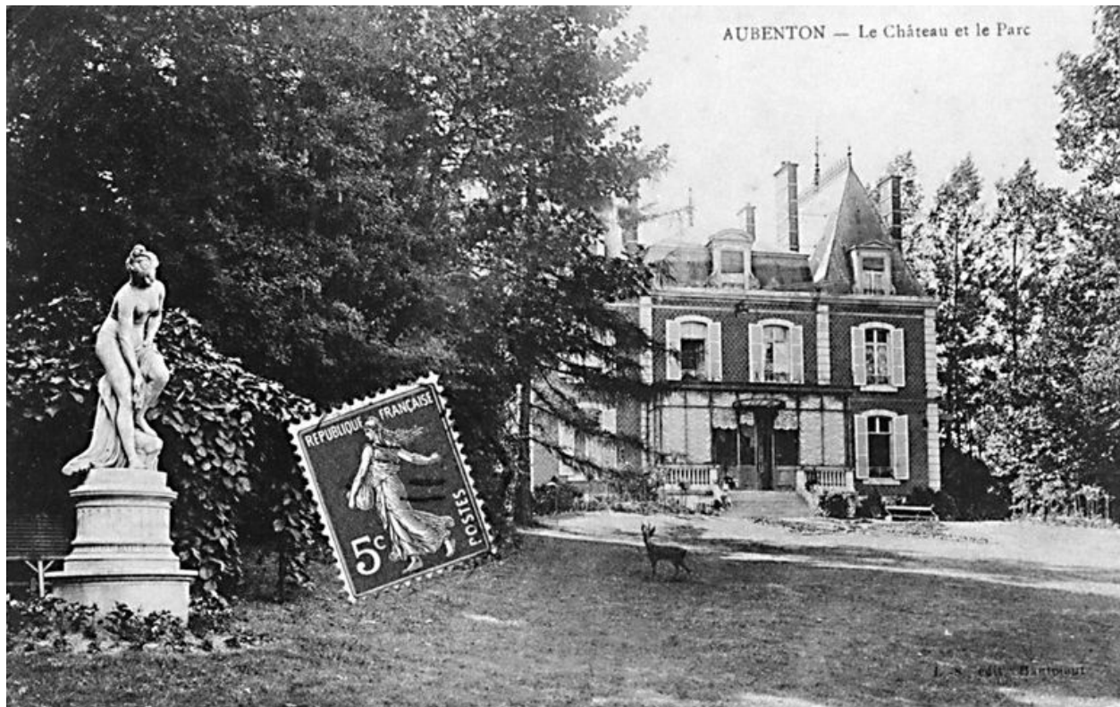
Vue, depuis l'est, de l'élévation sur parc (AP).
