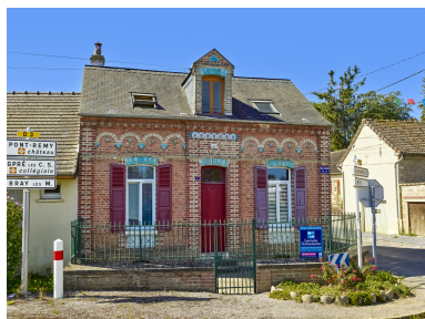
Vue de la maison depuis le nord. Phot. Thierry Lefébure IVR32_20248001158NUCA
