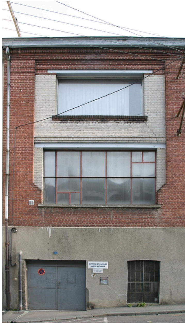
Travée d'atelier, rue Jean-de-Caulaincourt.
