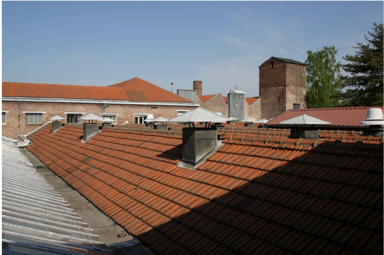
Vue des toitures des ateliers.
