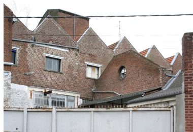
Ateliers et pignon de l'ancienne salle des machines, vus depuis la rue des Glacis. Phot. Frédéric Pillet IVR22_20070205109NUCA
