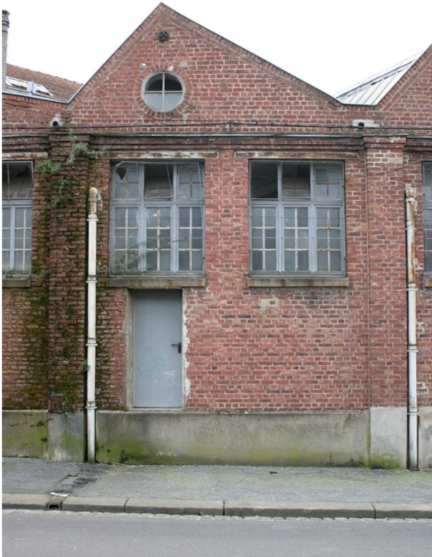
Détail de façade, rue des Glacis.
