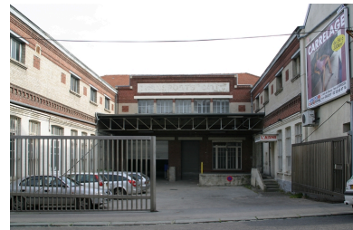
Cour de l'usine, rue Jean-de-Caulaincourt. Phot. Frédéric Pillet IVR22_20070205117NUCA
