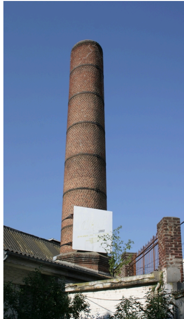
Cheminée de l'usine. Phot. Frédéric Pillet IVR22_20070205111NUCA
