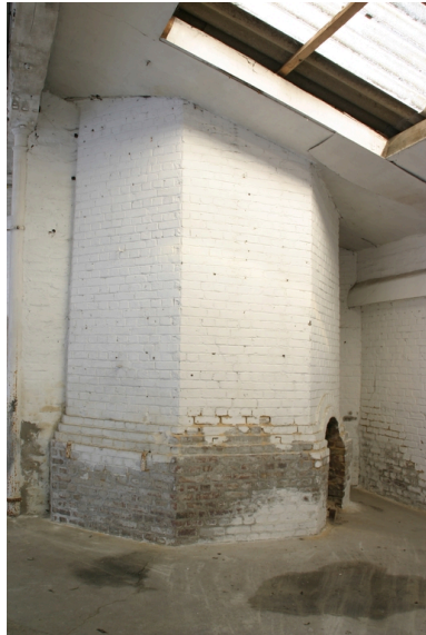
Base de la cheminée d'usine. Phot. Frédéric Pillet IVR22_20070205112NUCA
