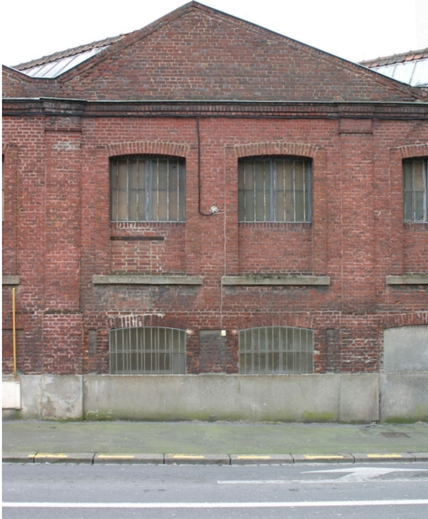
Détail de façade, rue des Glacis.
