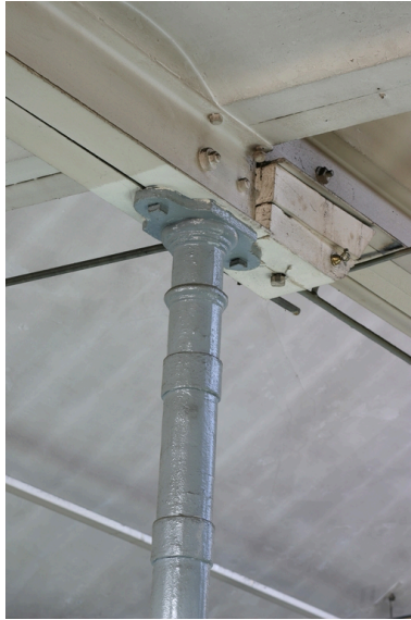
Détail d'une colonne (XIXe siècle). Phot. Frédéric Pillet IVR22_20070205122NUCA
