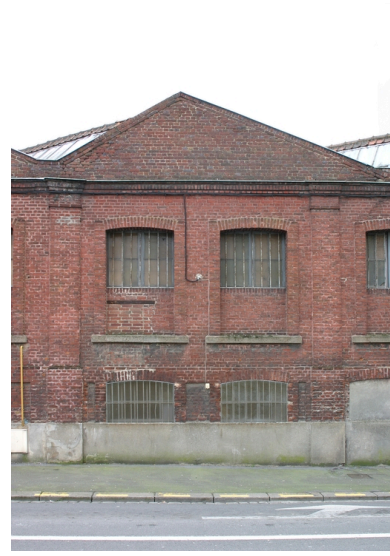
Détail de façade, rue des Glacis. Phot. Frédéric Pillet IVR22_20070205107NUCA
