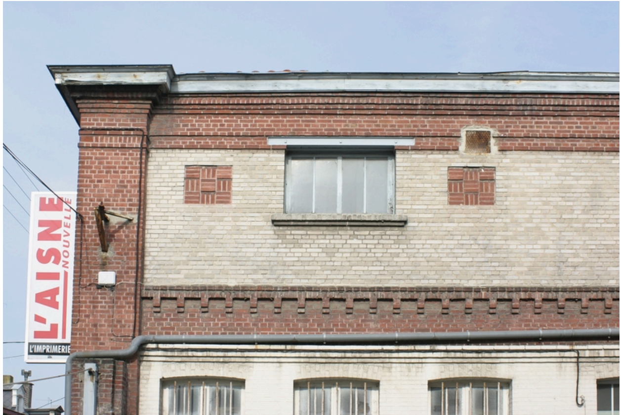
Jeu de brique rouge et silico-calcaire (façade sur cour rue Jean-de-Caulaincourt).
