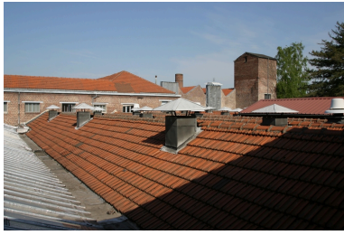
Vue des toitures des ateliers. Phot. Frédéric Pillet IVR22_20070205127NUCA
