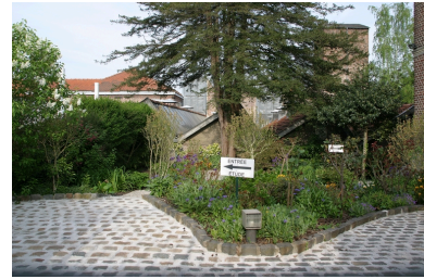
Les ateliers vus depuis la cour du logement patronal. Phot. Frédéric Pillet IVR22_20070205114NUCA
