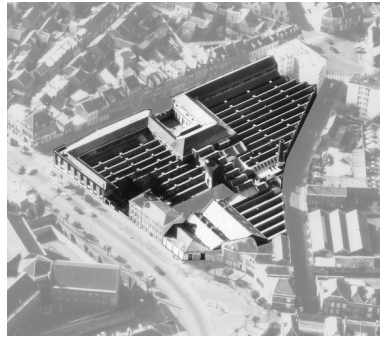
Vue aérienne du site en 1989. Phot. Pillet Frédéric, Autr. Phot'R IVR22_20060205605NUCA
