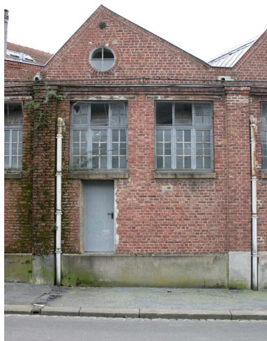
Détail de façade, rue des Glacis. Phot. Frédéric Pillet IVR22_20070205108NUCA
