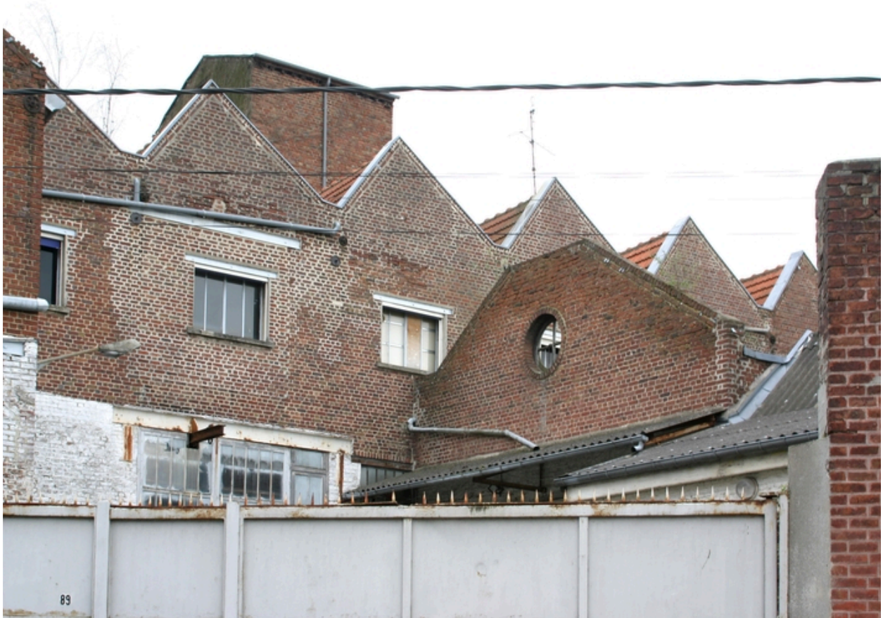
Ateliers et pignon de l'ancienne salle des machines, vus depuis la rue des Glacis.
