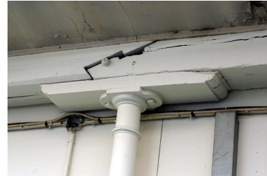
Détail d'une colonne (XIXe siècle). Phot. Frédéric Pillet IVR22_20070205123NUCA
