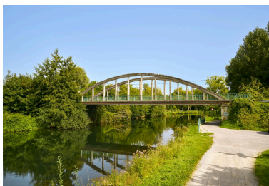
Pont entre Fontaine-sur-Somme et Cocquerel, depuis l'ouest. Phot. Thierry Lefébure IVR32_20238000633NUCA
