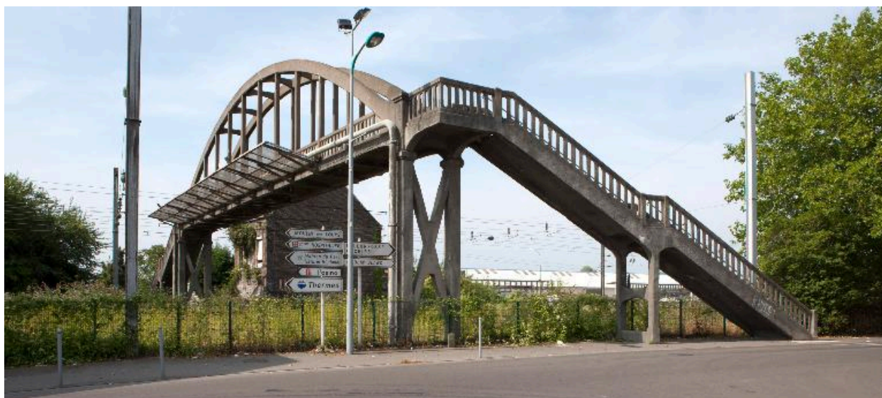
Passerelle piétonne située face à la rue Marillon permettant d'enjamber le chemin de fer.
