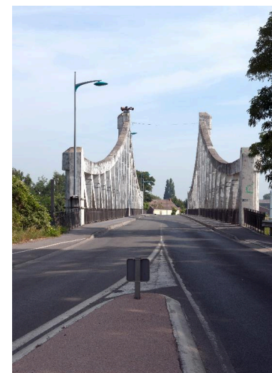
Vue de face du pont de chemin de fer. Phot. Pierre Thibaut IVR31_20125902053NUCA
