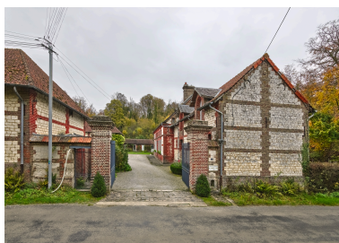
Vue de l'entrée sud de la ferme. Phot. Thierry Lefébure IVR32_20248001491NUCA
