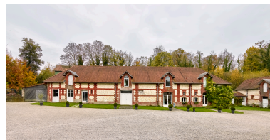
Vue de l'ancienne étable, depuis la cour. Phot. Thierry Lefébure IVR32_20248001506NUCA
