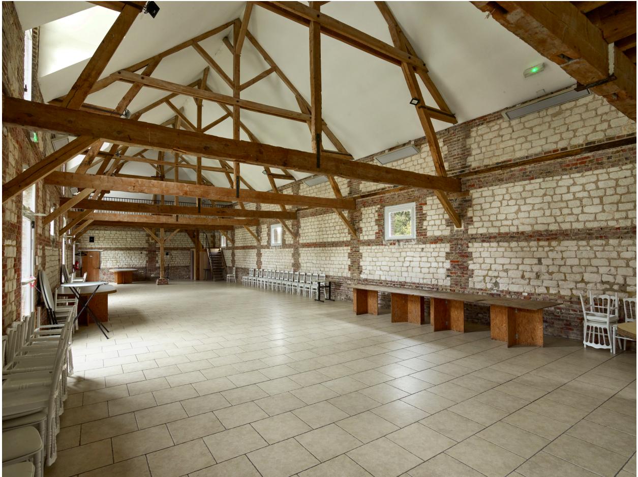
Intérieur de l'ancienne bergerie.
