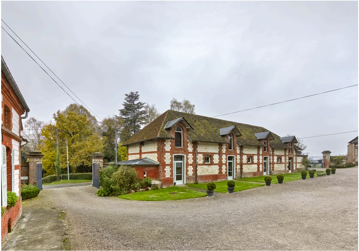
Vue de l'ancienne bergerie, depuis l'est.
