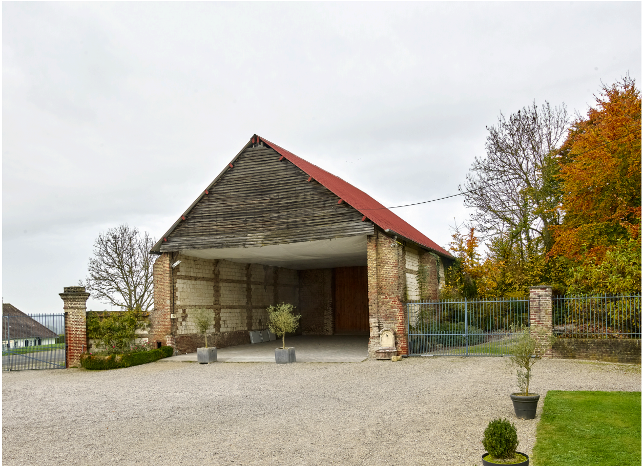
Vue du hangar nord, depuis l'est.
