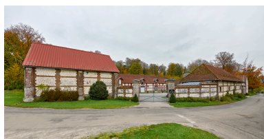
Vue d'ensemble de la ferme, depuis la rue. Phot. Thierry Lefébure IVR32_20248001489NUCA
