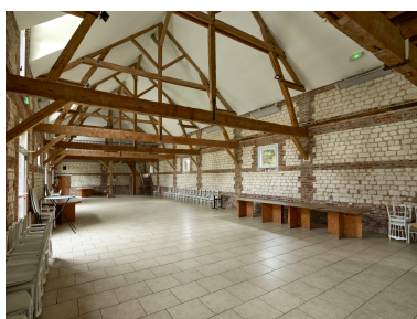
Intérieur de l'ancienne bergerie. Phot. Thierry Lefébure IVR32_20248001508NUCA
