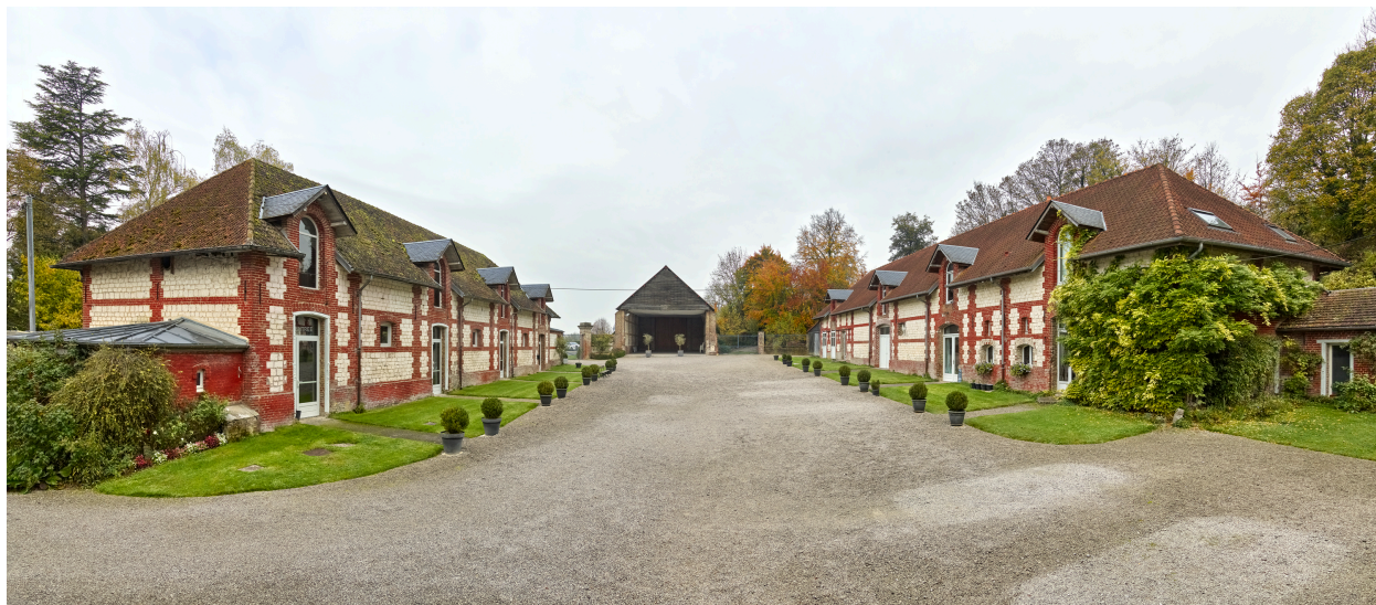
Vue de la cour, depuis l'est.
