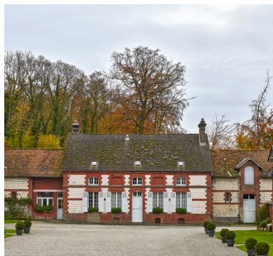
Vue de la maison, depuis l'ouest. Phot. Thierry Lefébure IVR32_20248001495NUCA
