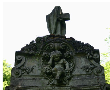
Vue de détail de la partie supérieure du tombeau. Phot. Caroline Vincent IVR22_20088000821NUCA
