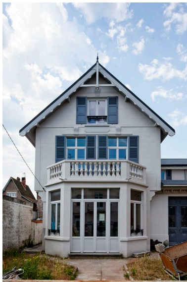
Vue générale du volume principal. Phot. Hubert Bouvet IVR31_20136200165NUCA
