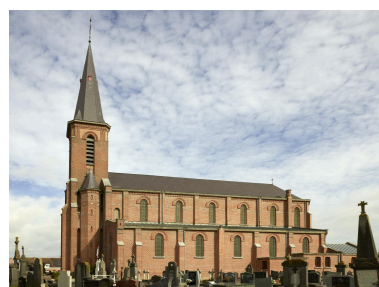
Vue du côté sud de l'église. Phot. Delphine Volto Jourdan IVR32_20235901249NUCA
