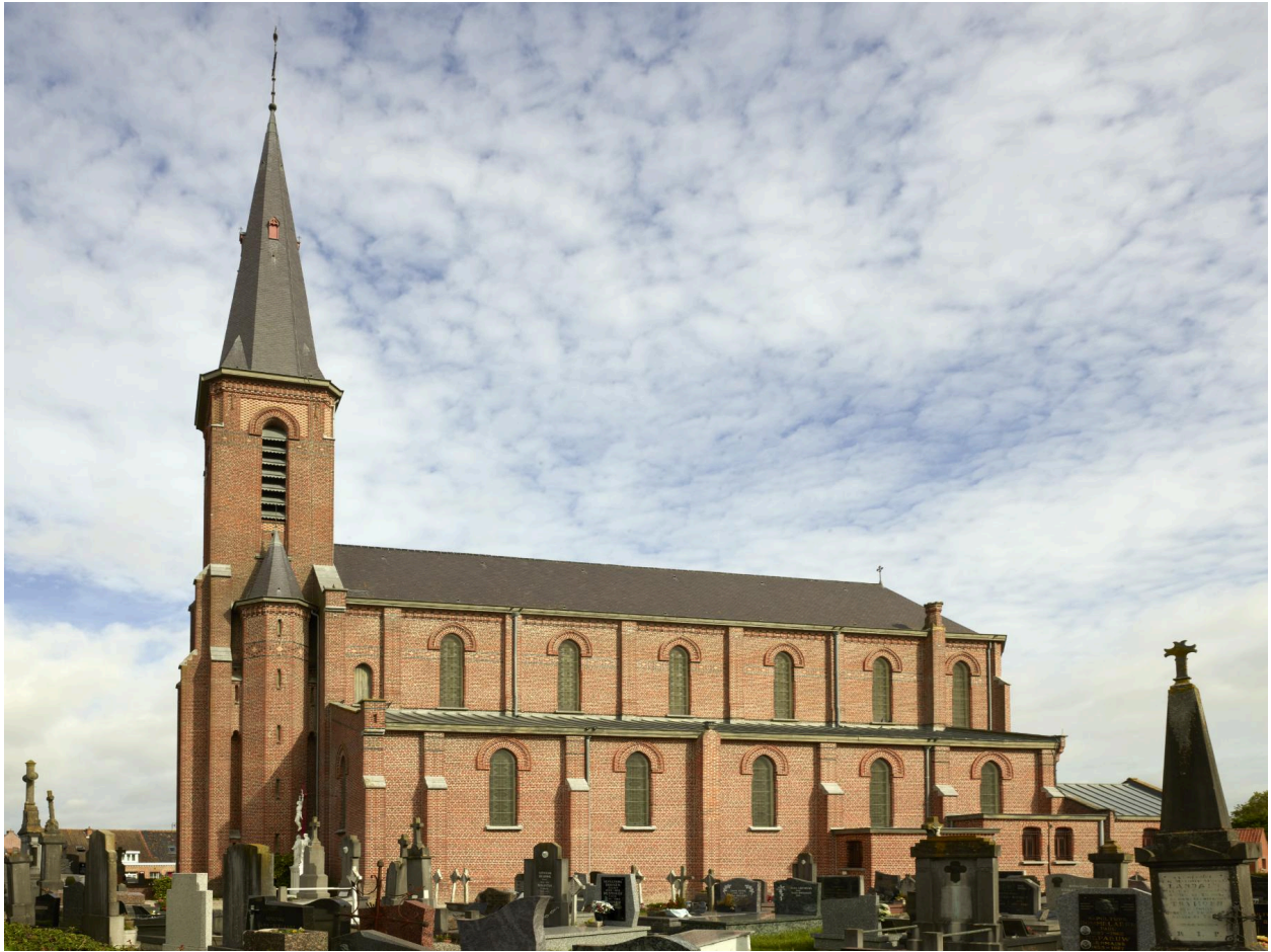
Vue du côté sud de l'église.
