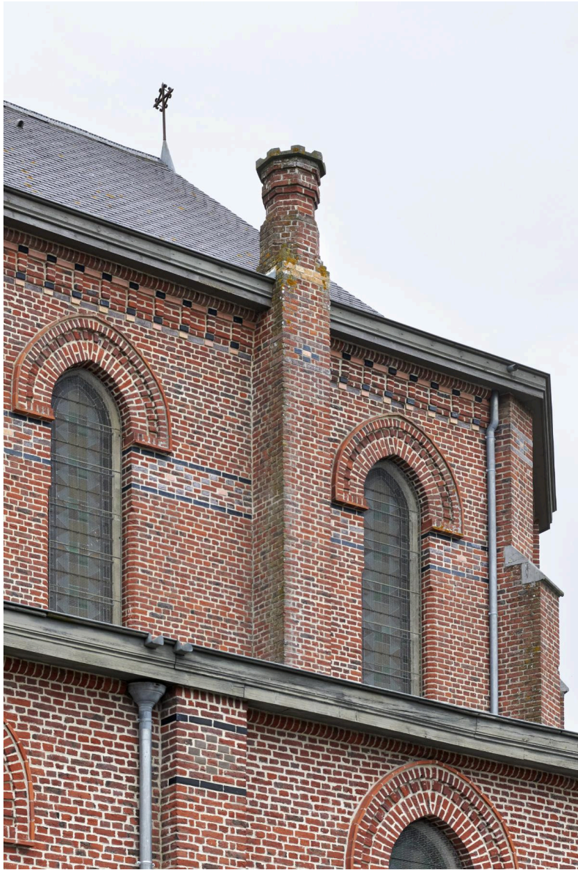
Détail des couronnements supérieurs.
