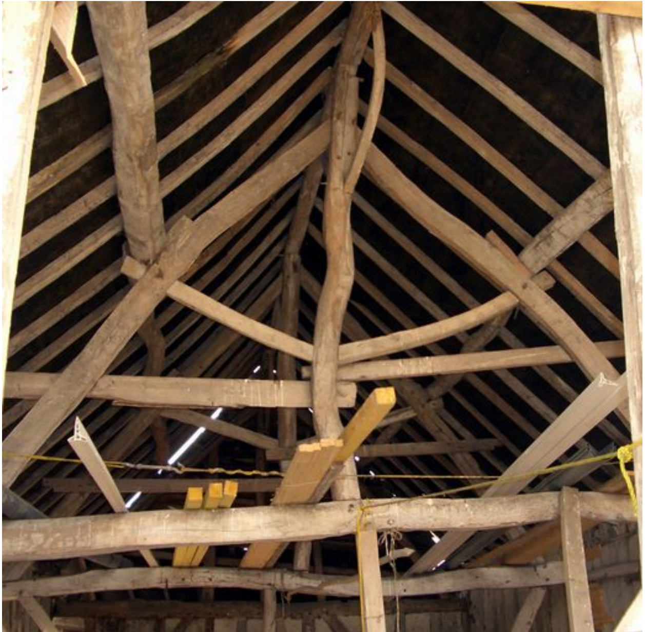
Vue détaillée de la charpente de la grange.
