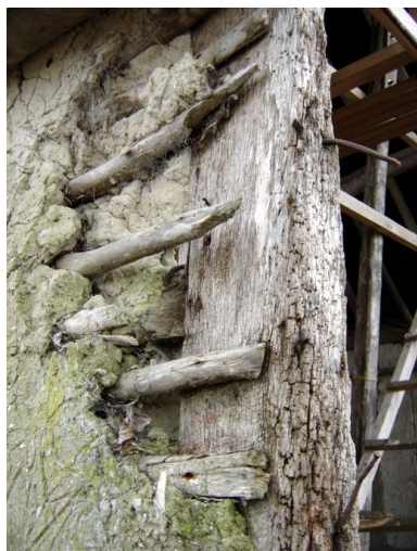
Détail du lattis et du torchis de la grange. Phot. Inès Guérin IVR22_20058005081NUCA
