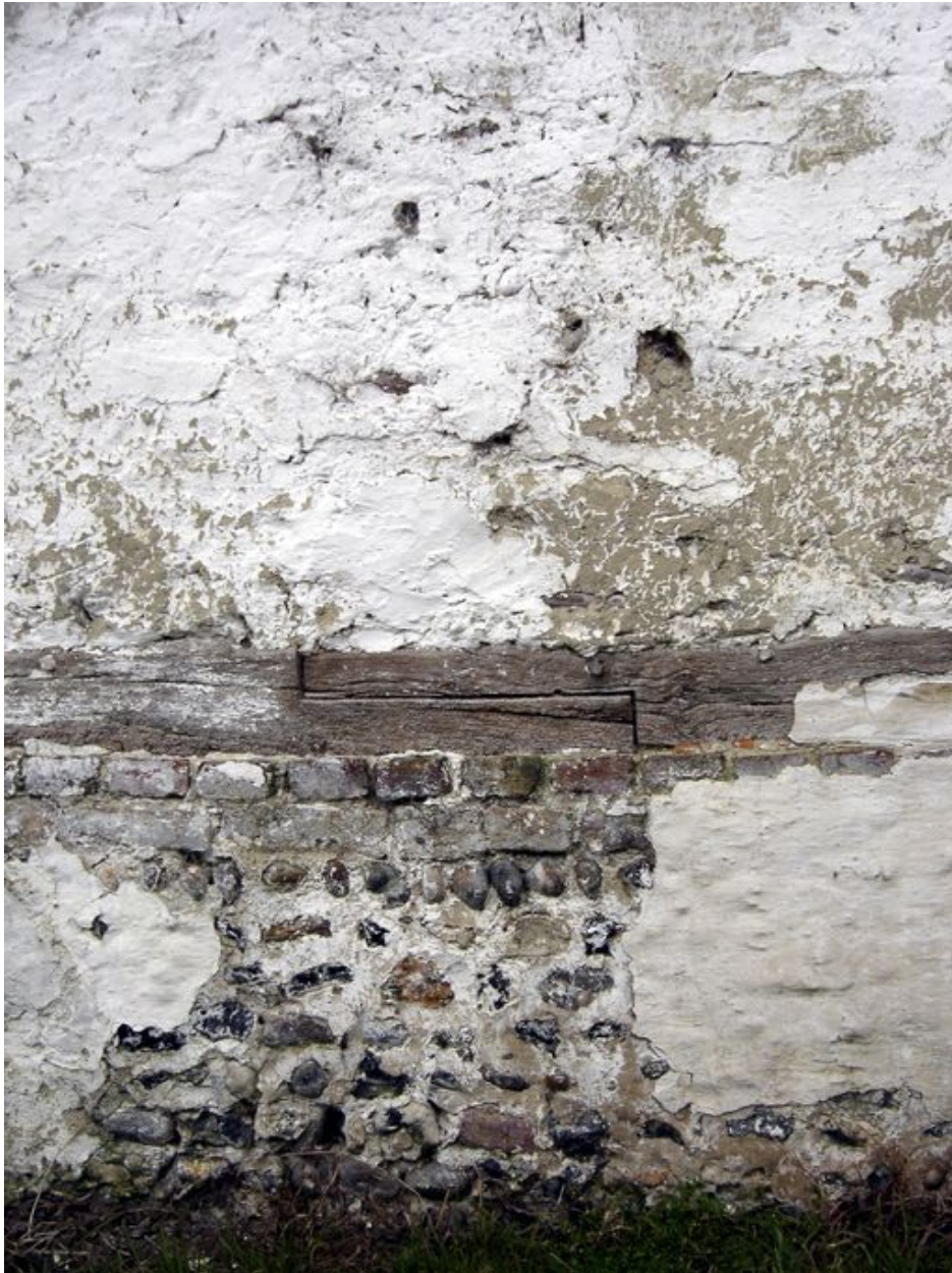
Détail du solin en silex et briques ainsi que de la sablière basse à assemblage à mi-bois de la grange.
