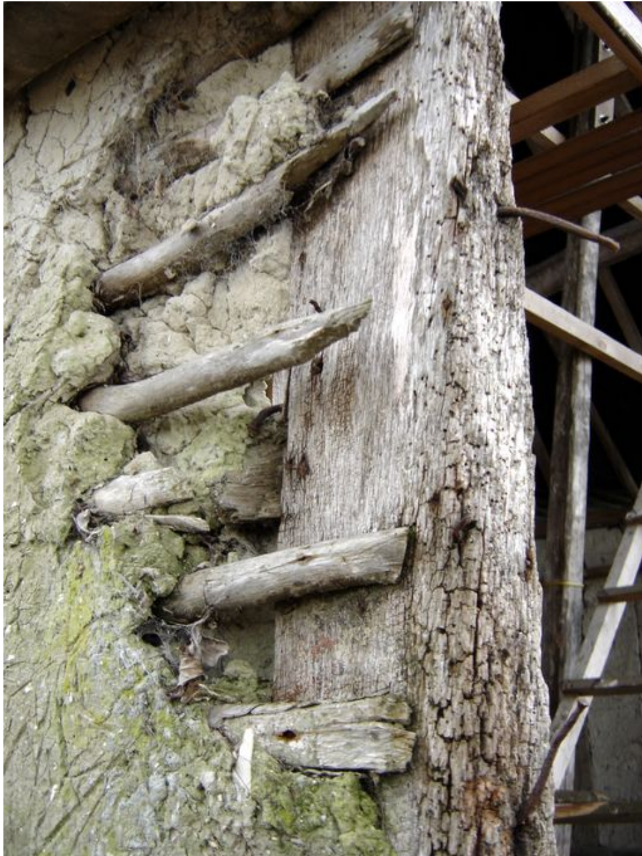
Détail du lattis et du torchis de la grange.
