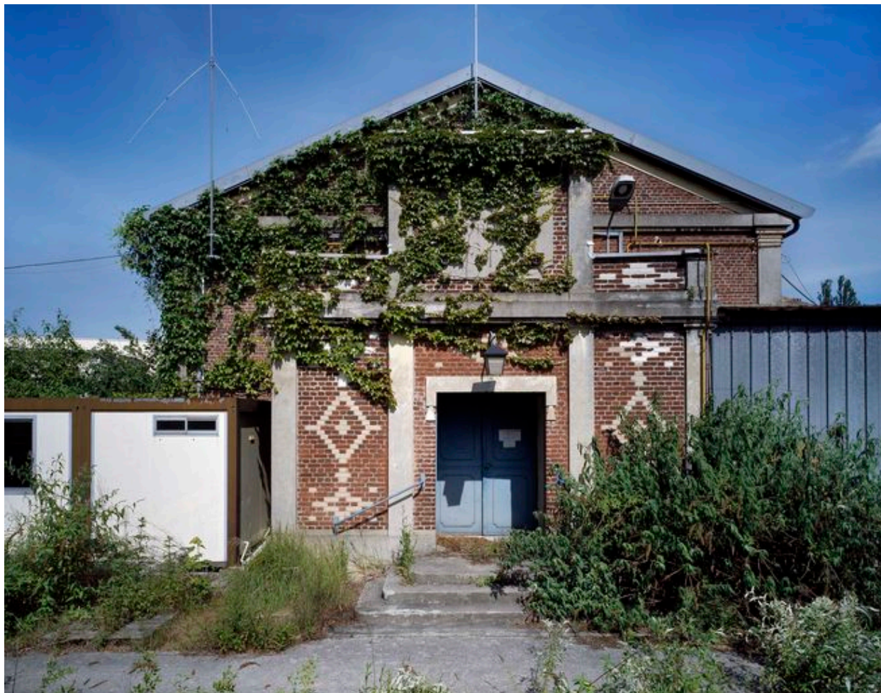
Façade principale de la salle des fêtes.
