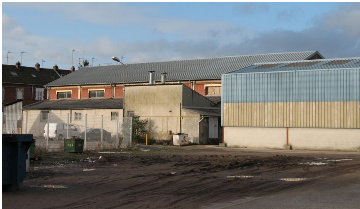
Façade sud de la salle des fêtes.
