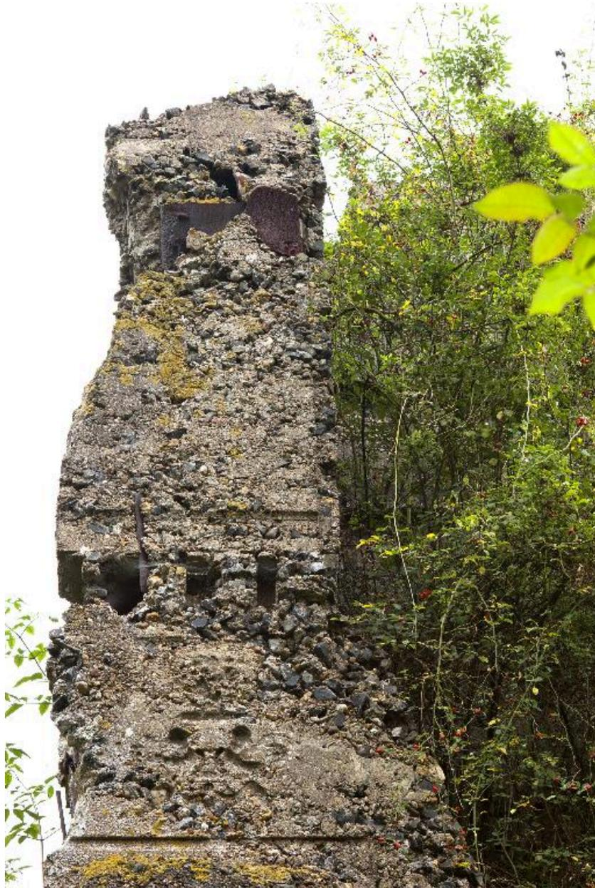
Détail du contrefort est où apparaissent des fragments de blindage (en haut) ainsi que les empreintes des bois de coffrage moulurés utilisés : une porte (à droite), des angelots (en bas)
