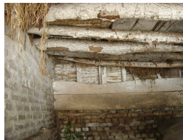
Vue détaillée du plafond.
