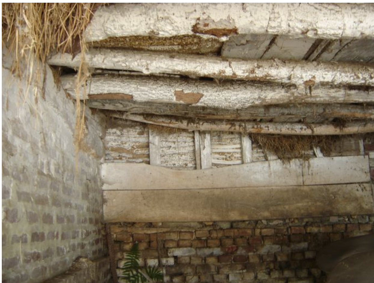
Vue détaillée du plafond.
