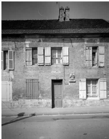
Détail de l'élévation sur la rue, avec le chapiteau en remploi. Phot. Thierry Lefébure IVR22_19930200911V
