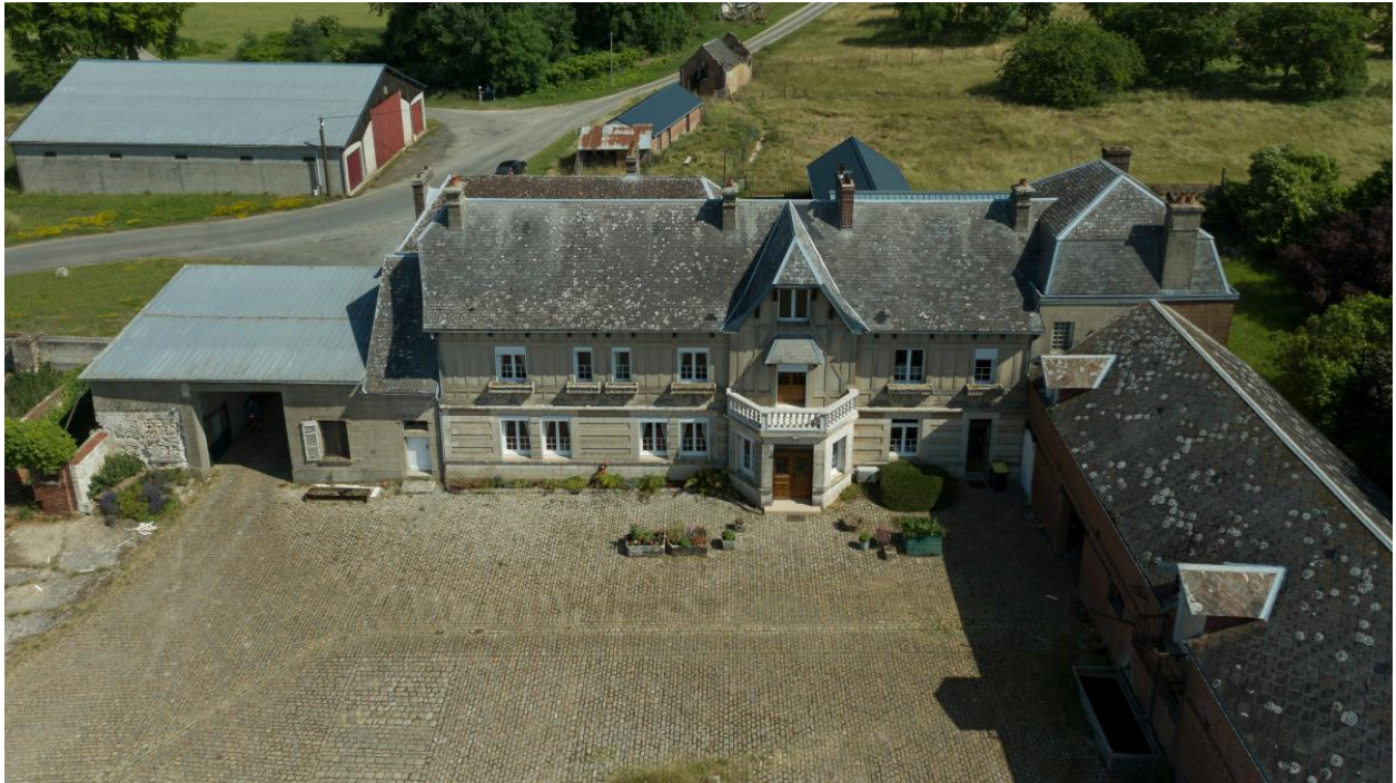
Vue aérienne du logis et de la porterie depuis le sud.
