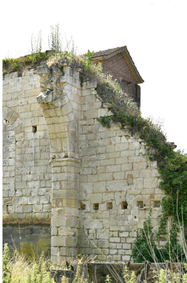
Mur intérieur du pignon sud, côté ouest. Phot. Marc Kérignard IVR32_20226000483NUCA
