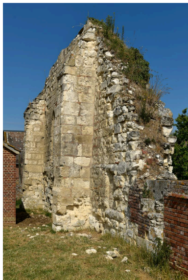
Pignon sud : contreforts. Phot. Marc Kérignard IVR32_20226000480NUCA
