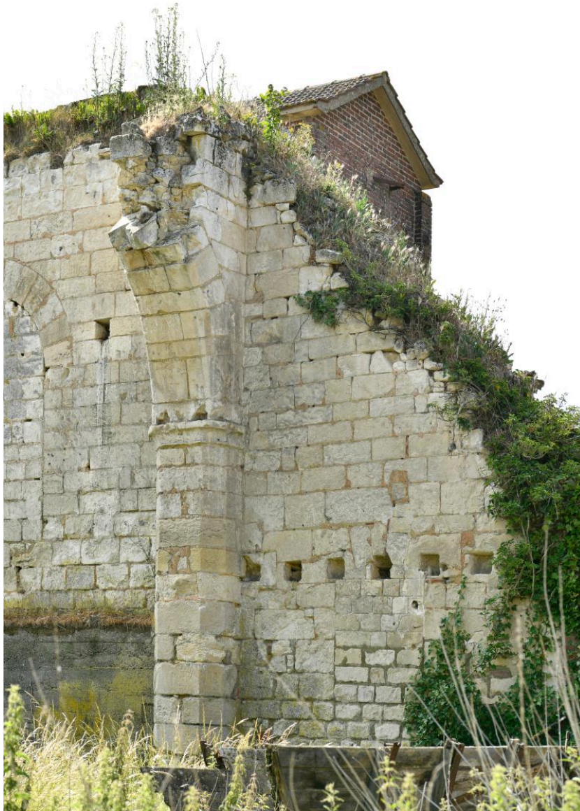
Mur intérieur du pignon sud, côté ouest.
