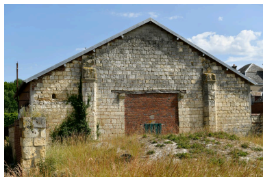
Mur intérieur du pignon nord. Phot. Marc Kérignard IVR32_20226000485NUCA
