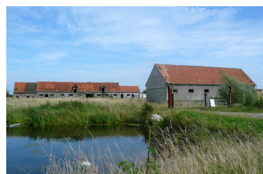
Vue sur les bâtiments nord. Phot. Inès Guérin IVR22_20048001103NUCA
