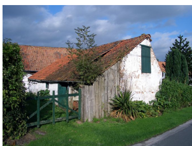
Vue postérieure de l'annexe. Phot. Inès Guérin IVR22_20078005052NUCA
