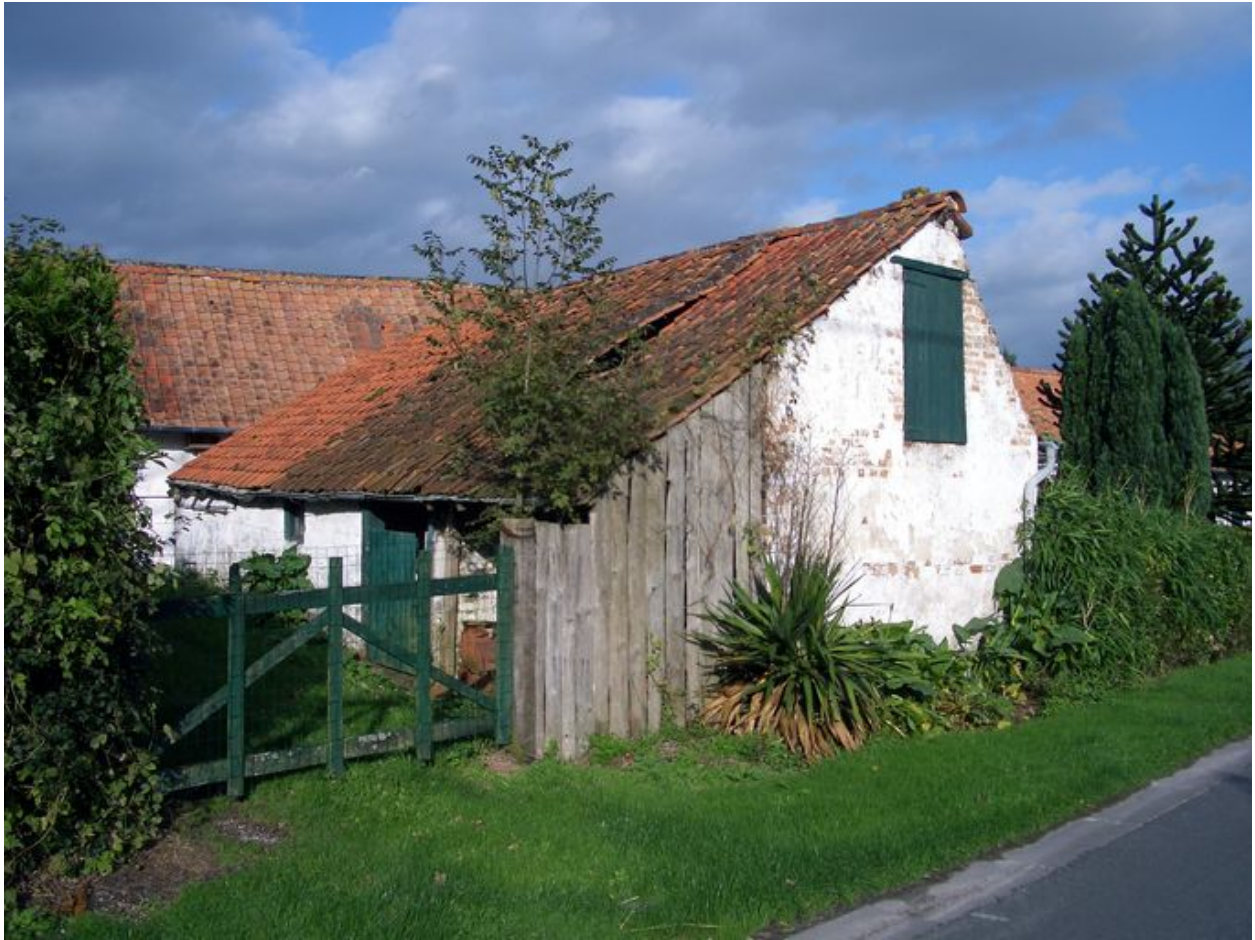
Vue postérieure de l'annexe.
