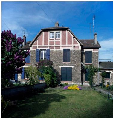
Maison jumelée de la cité. Phot. Thierry Lefébure IVR22_20106000364XA
