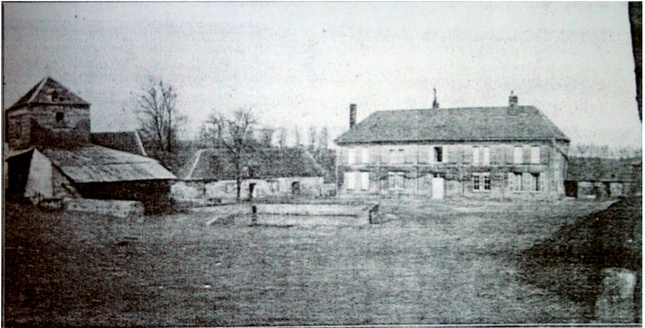
Vue ancienne du logis (coll. part).
