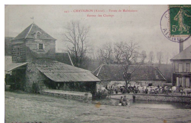
Vue ancienne de la ferme (coll. part). Phot. Inès Guérin IVR22_20030202270NUCAB
