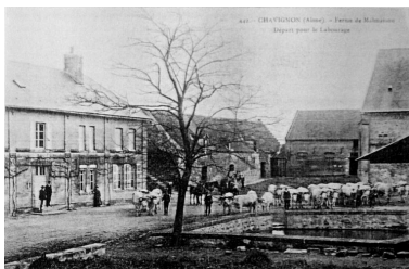
Vue ancienne des bâtiments agricoles (coll. part). Phot. Inès Guérin IVR22_20030202272NUCAB
