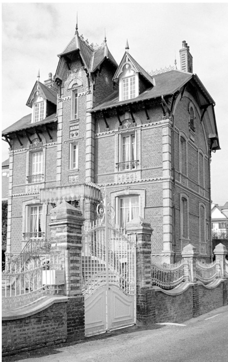
Logement patronal, élévation antérieure.
