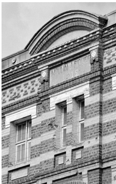
Atelier de fabrication : détail. Phot. Francis Dubuc IVR22_19908000555Z
