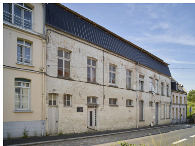
Ancienne école Sainte-Thérèse, aujourd'hui désaffectée - 35-37, rue de la Nouvelle- Zélande : façade avant. Phot. Pierre Thibaut IVR32_20245900349NUCA
