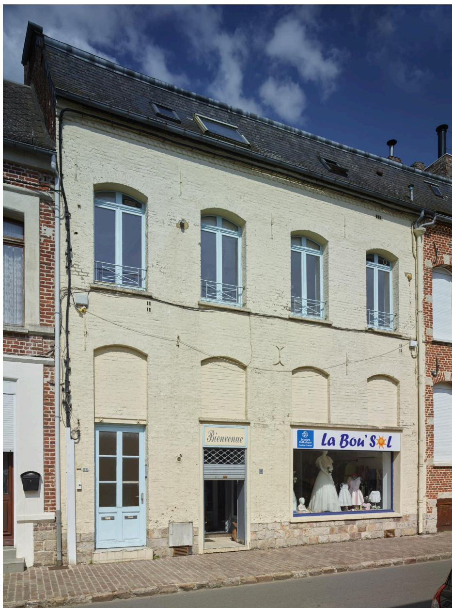
Ancienne école des Sœurs de Sainte-Thérèse d'Avesnes - 16-18, rue du Général-Bouttiaux : détail de la partie modifiée de la façade.
