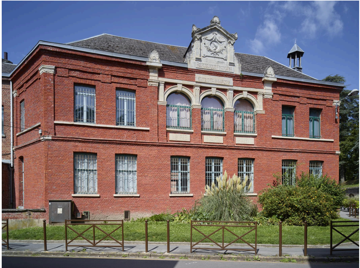
École de garçons puis école primaire Chevray : vue de la façade sur la rue Chevray.
