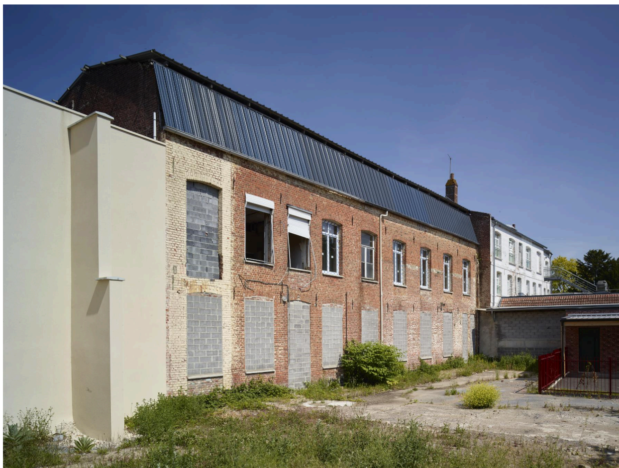
Ancienne école Sainte-Thérèse, aujourd'hui désaffectée - 35-37, rue de la Nouvelle-Zélande : façade arrière.
