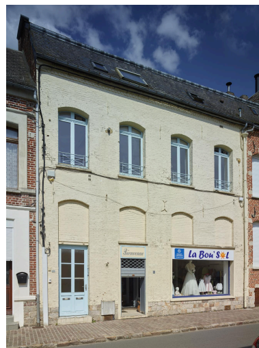
Ancienne école des Sœurs de Sainte- Thérèse d'Avesnes - 16-18, rue du Général-Bouttiaux : détail de la partie modifiée de la façade. Phot. Pierre Thibaut IVR32_20235901108NUCA
