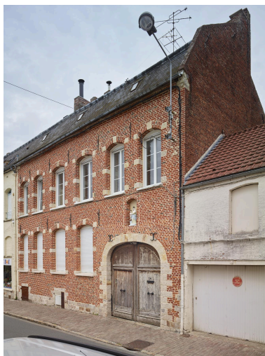
Ancienne école des Sœurs de Sainte-Thérèse d'Avesnes - 16-18, rue du Général-Bouttiaux : détail de la partie non modifiée de la façade, vue orientée est-ouest. Phot. Pierre Thibaut IVR32_20245900363NUCA
