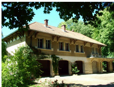
Vue des dépendances. Phot. Inès Guérin IVR22_20030202165NUCA
