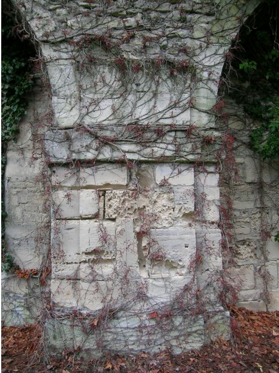
Détail des soubassements endommagés.
