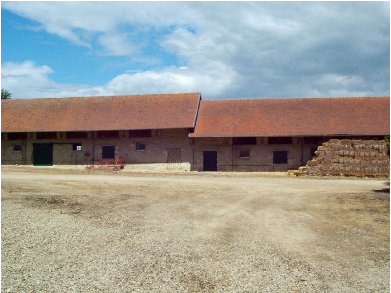
Dépendances de la ferme du château.
