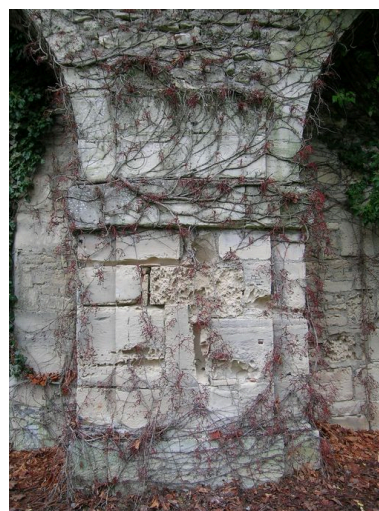
Détail des soubassements endommagés. Phot. Pascale Touzet IVR22_20050200621NUCA
