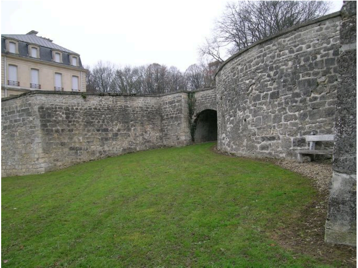
Soubassement de la terrasse percé d'un passage
