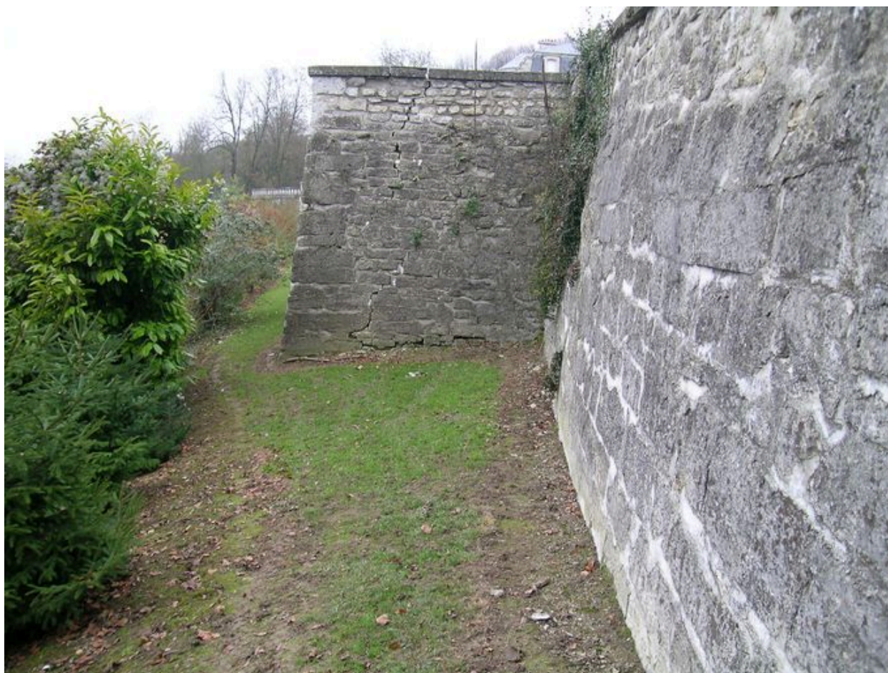
Soubassements de la terrasse
