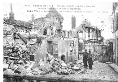
Destruction de la quincaillerie Vivien à Creil (AC Creil ; fonds local). Repro. Clarisse Lorieux IVR22_20076005225NUCAB
