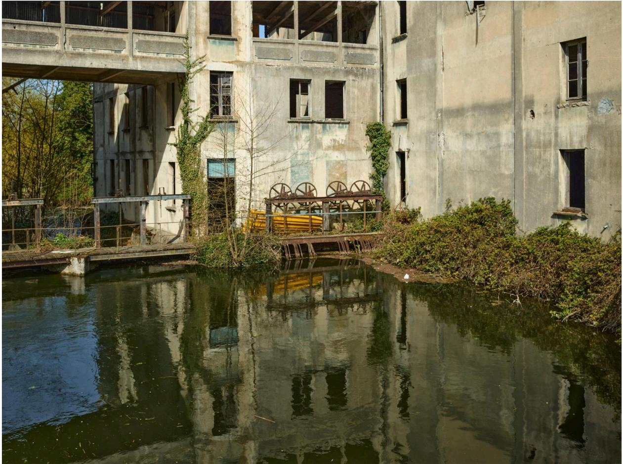
Vannage de la petite roue hydraulique.
