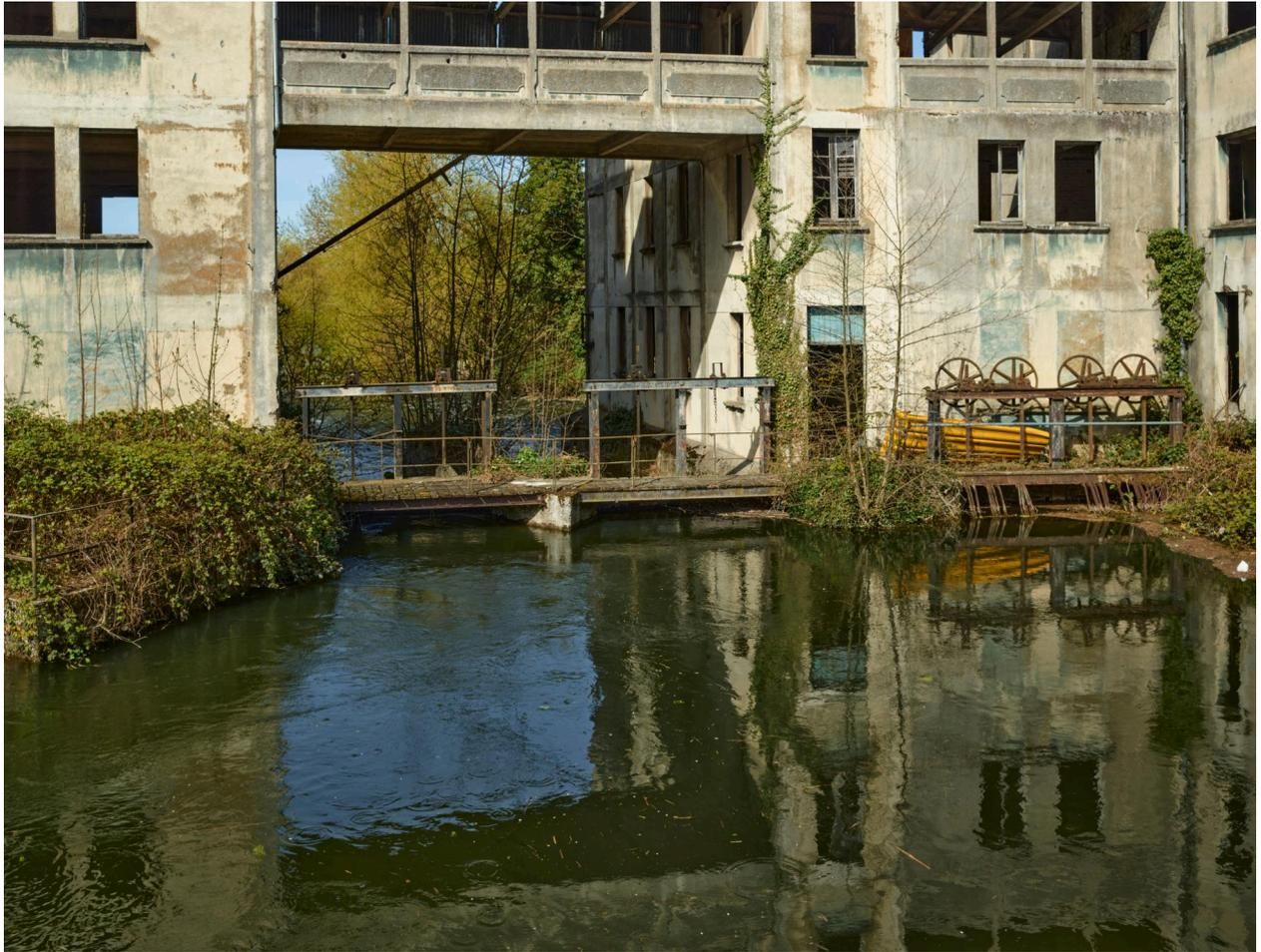
Vannage ouvrier de l'ancienne petite roue hydraulique, remplacée par une turbine.
