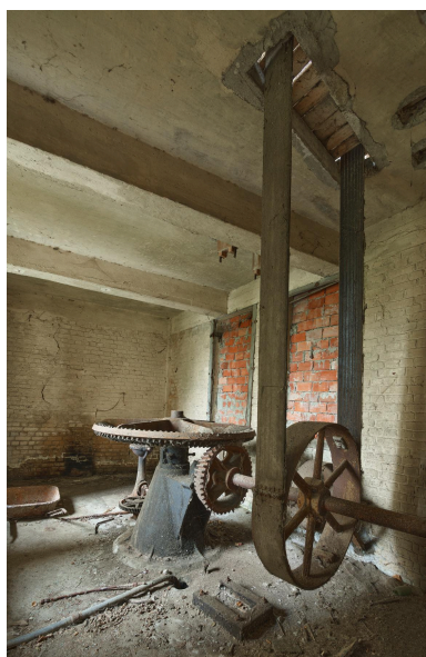
Turbine et sa courroie de transmission. Phot. Thierry Lefébure IVR32_20228000079NUCA
