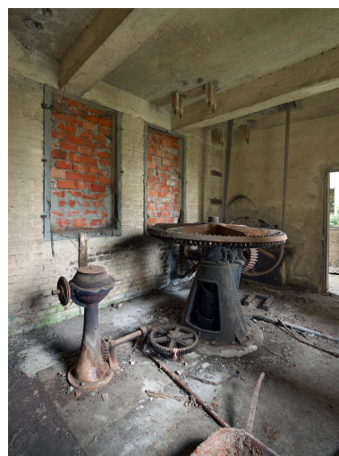
Turbine de la minoterie. Phot. Thierry Lefébure IVR32_20228000078NUCA
