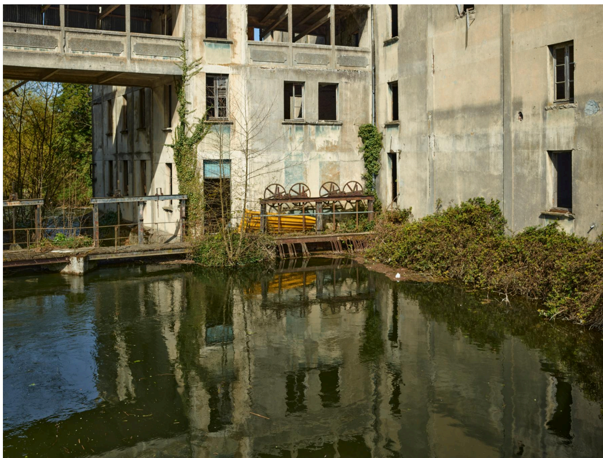
Vannage de la petite roue hydraulique.
