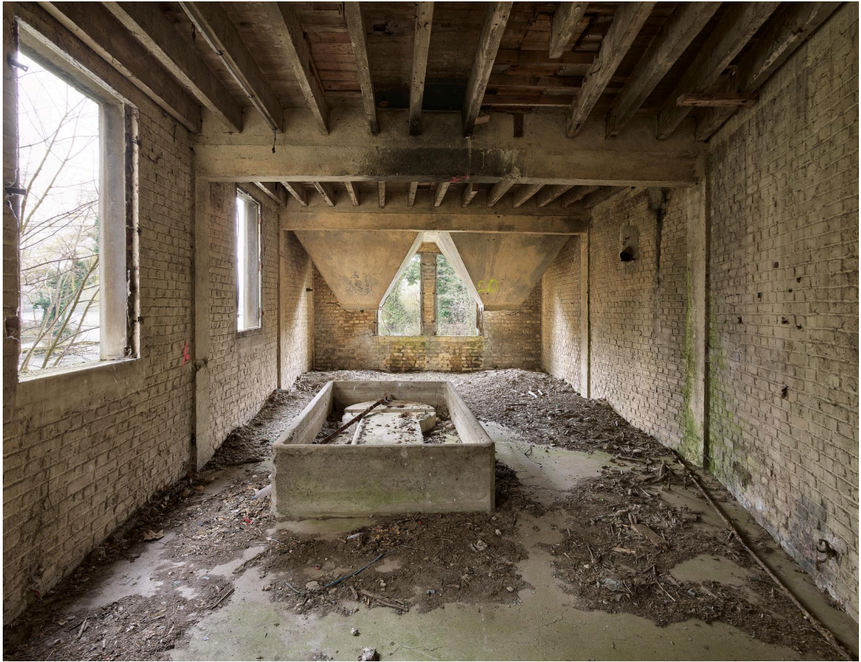
Salle à deux trémis en béton.
