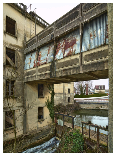
Galerie surplombant la coulerie centrale de la minoterie. Phot. Thierry Lefébure IVR32_20228000070NUCA
