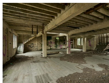
Salle des sasseurs. Phot. Thierry Lefébure IVR32_20228000085NUCA
