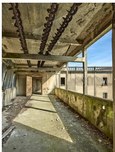
Passerelle reliant les deux corps de bâtiments de la minoterie. Phot. Thierry Lefébure IVR32_20228000097NUCA
