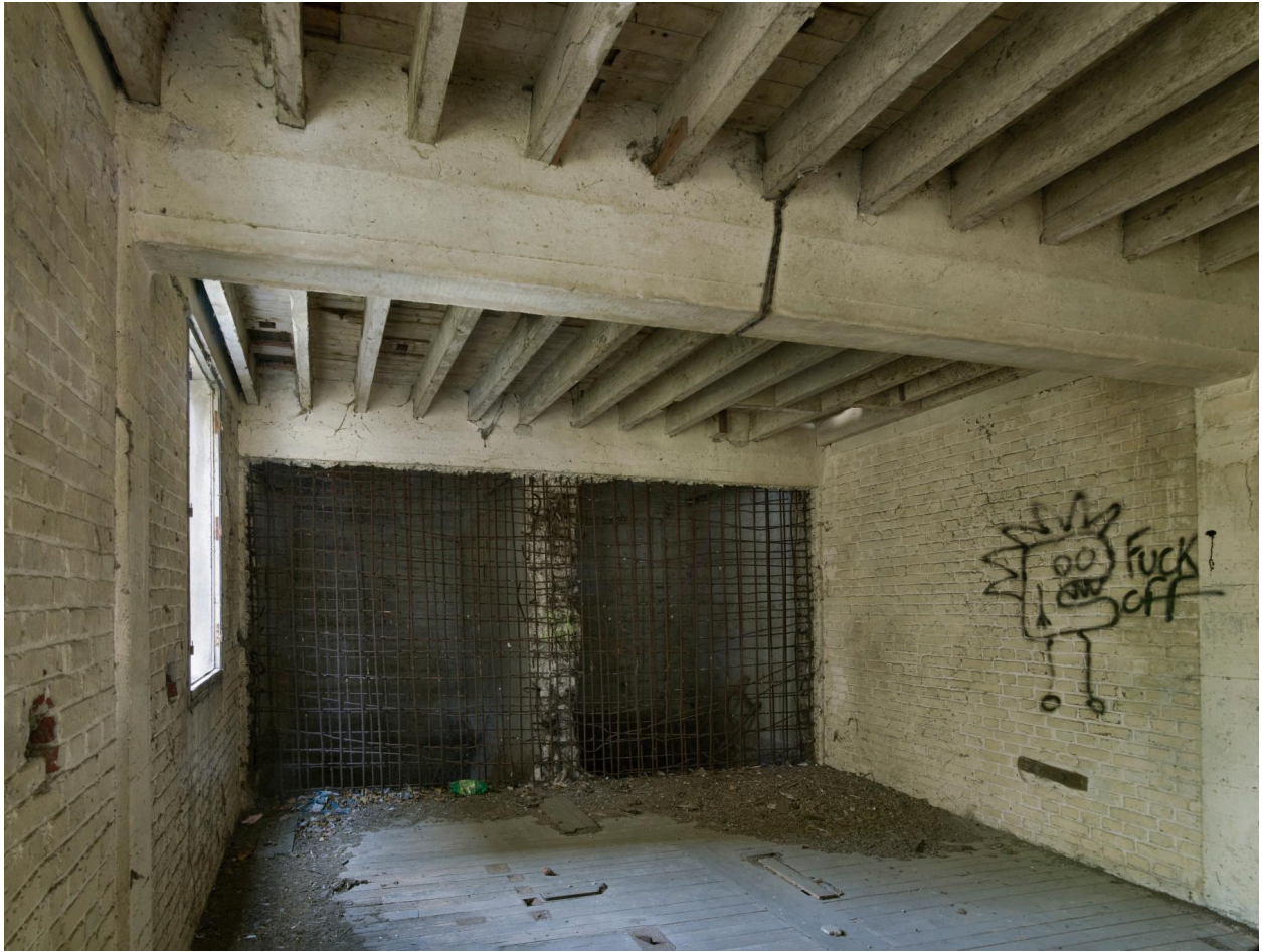
Intérieur du premier niveau de la minoterie, détail du réseau de ferrailage d'un des murs en béton armé.
