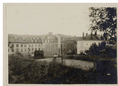
La minoterie et la demeure patronale, à droite de l'image. Photographie, quatrième quart du XIX e siècle (AD Somme ; 10 R 1013). Repro. Archives départementales de la Somme IVR32_20218005227NUCA
