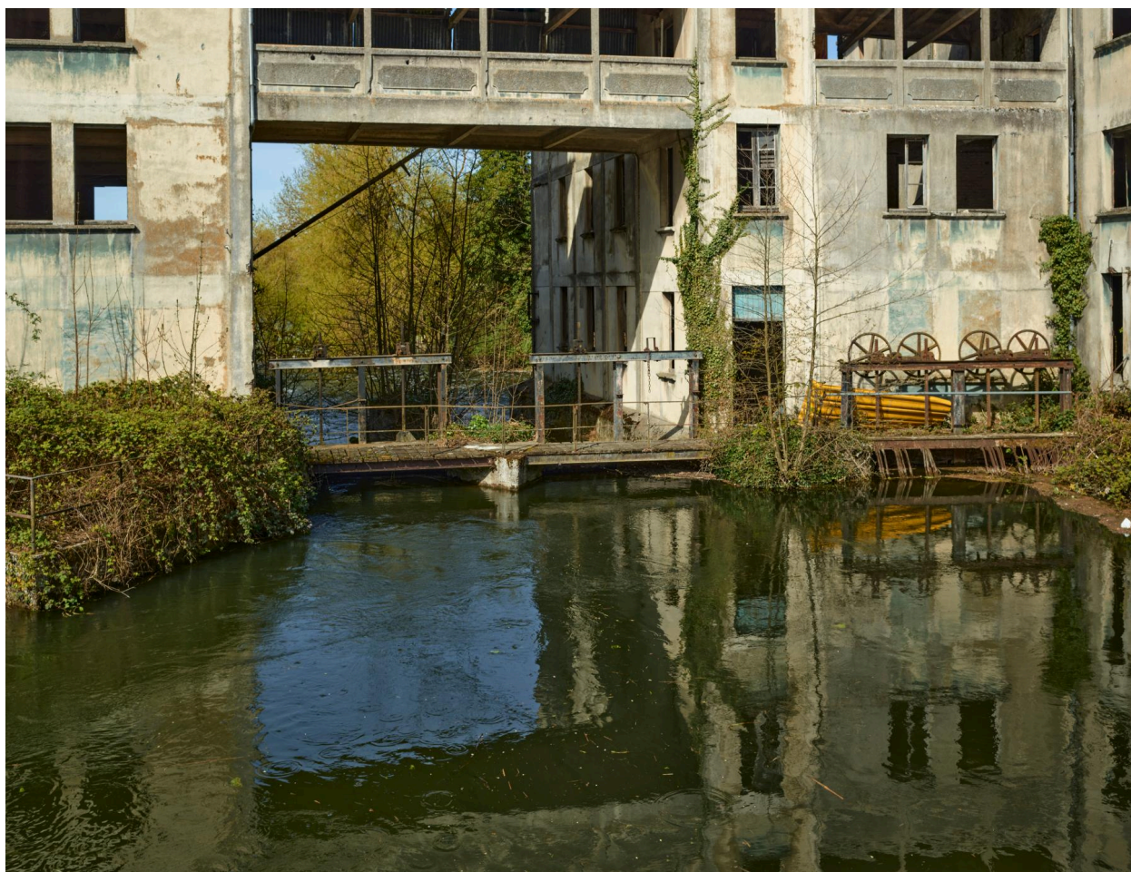
Vannage ouvrier de l'ancienne petite roue hydraulique, remplacée par une turbine.
