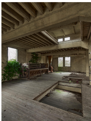
Ancienne salle des plansichters. Phot. Thierry Lefébure IVR32_20228000087NUCA
