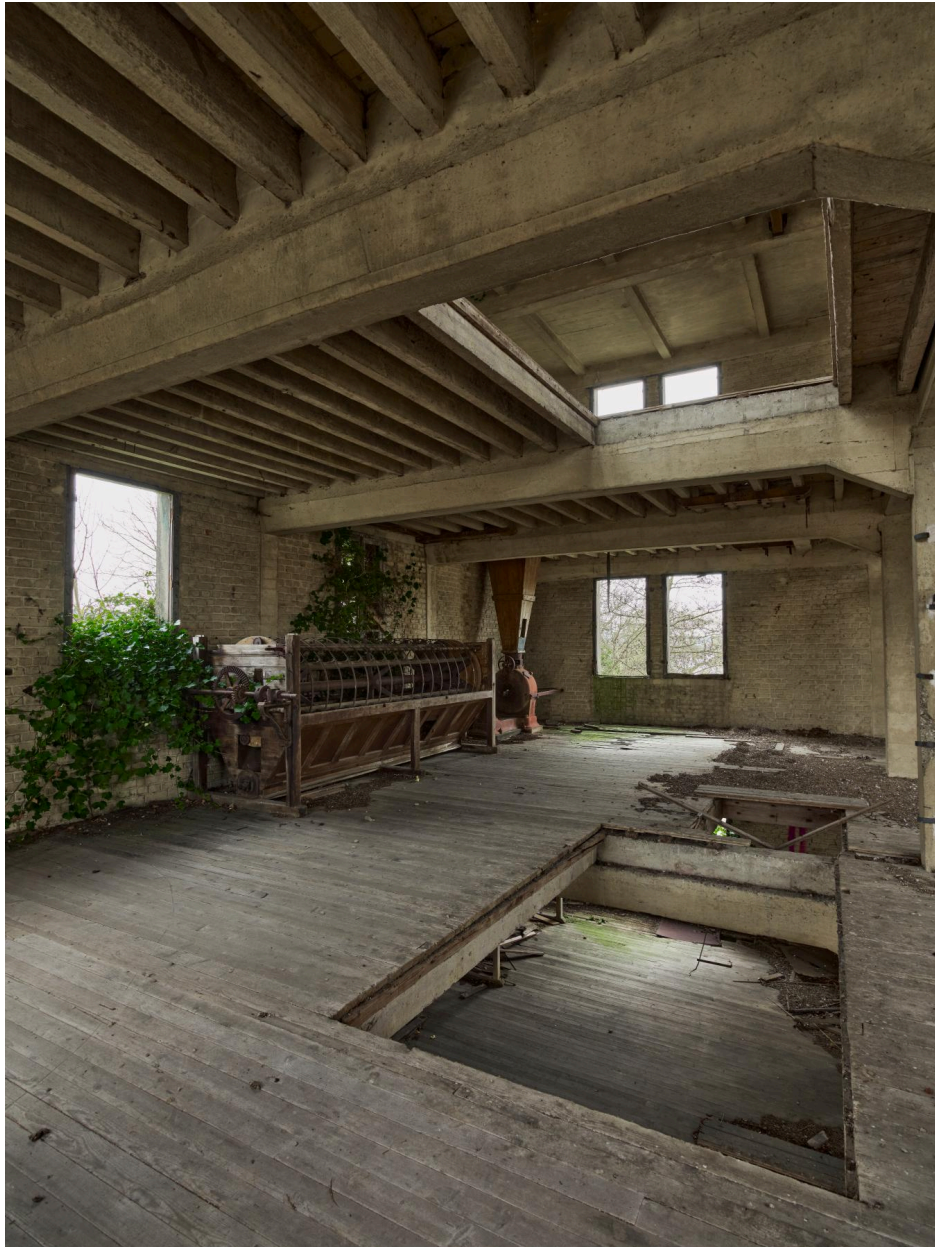
Ancienne salle des plansichters.
