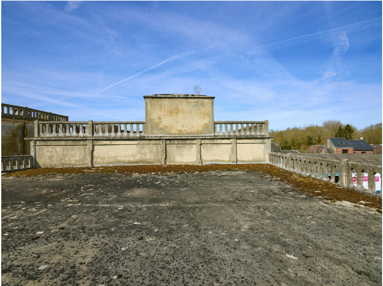
Toit-terrasse de la minoterie.
