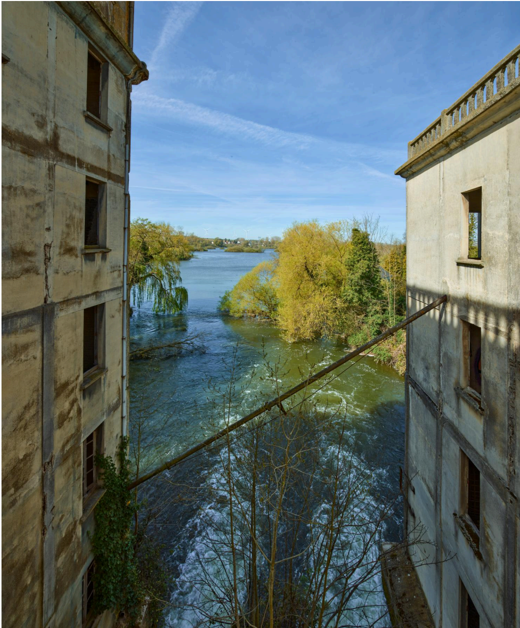
La coulerie depuis la passerelle et la vue sur la Somme, en aval.
