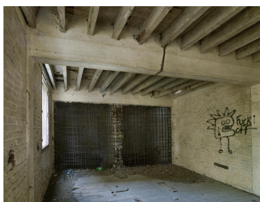
Intérieur du premier niveau de la minoterie, détail du réseau de ferrailage d'un des murs en béton armé. Phot. Thierry Lefébure IVR32_20228000104NUCA
