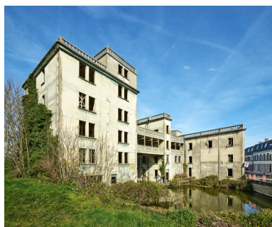
Vue générale sud-est de la minoterie. Phot. Thierry Lefébure IVR32_20228000107NUCA
