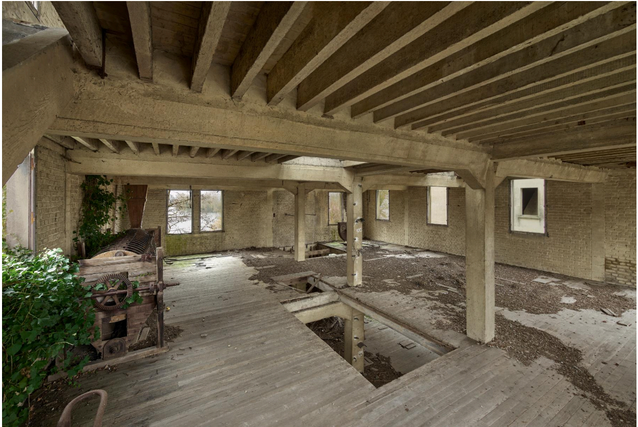
Intérieur du deuxième étage de la minoterie.
