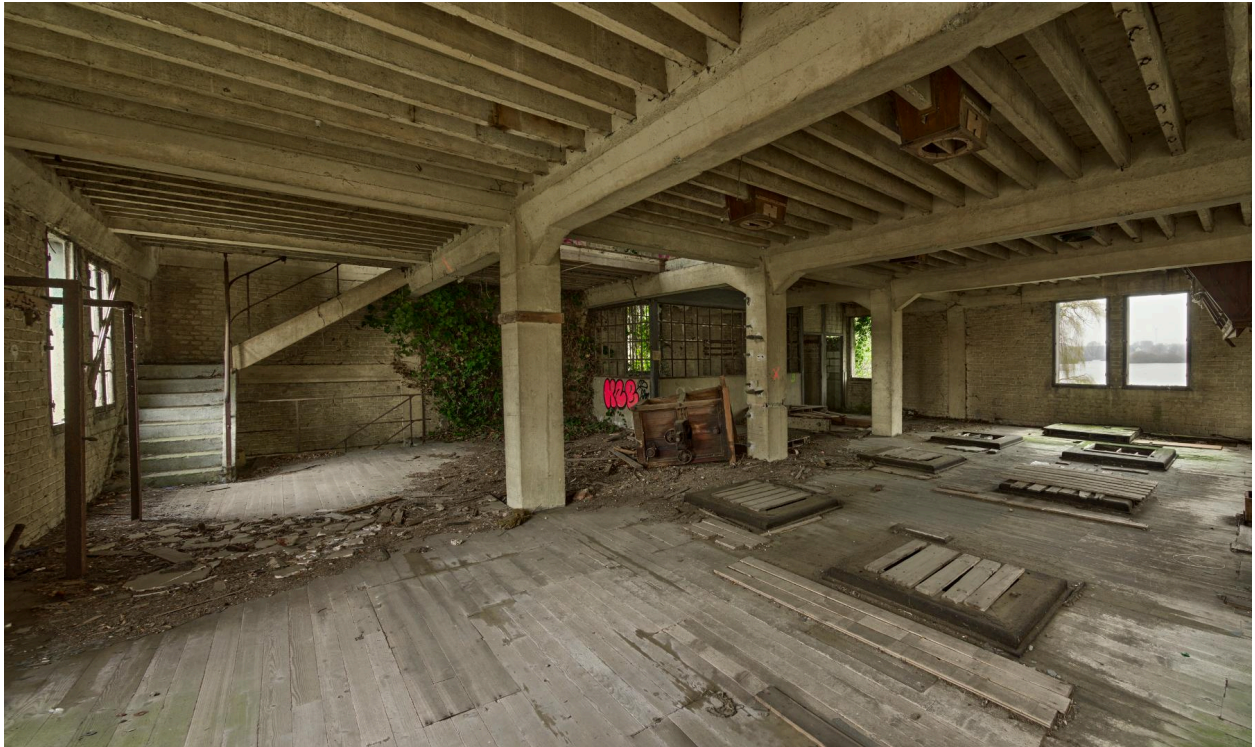
Intérieur du deuxième étage de la minoterie.
