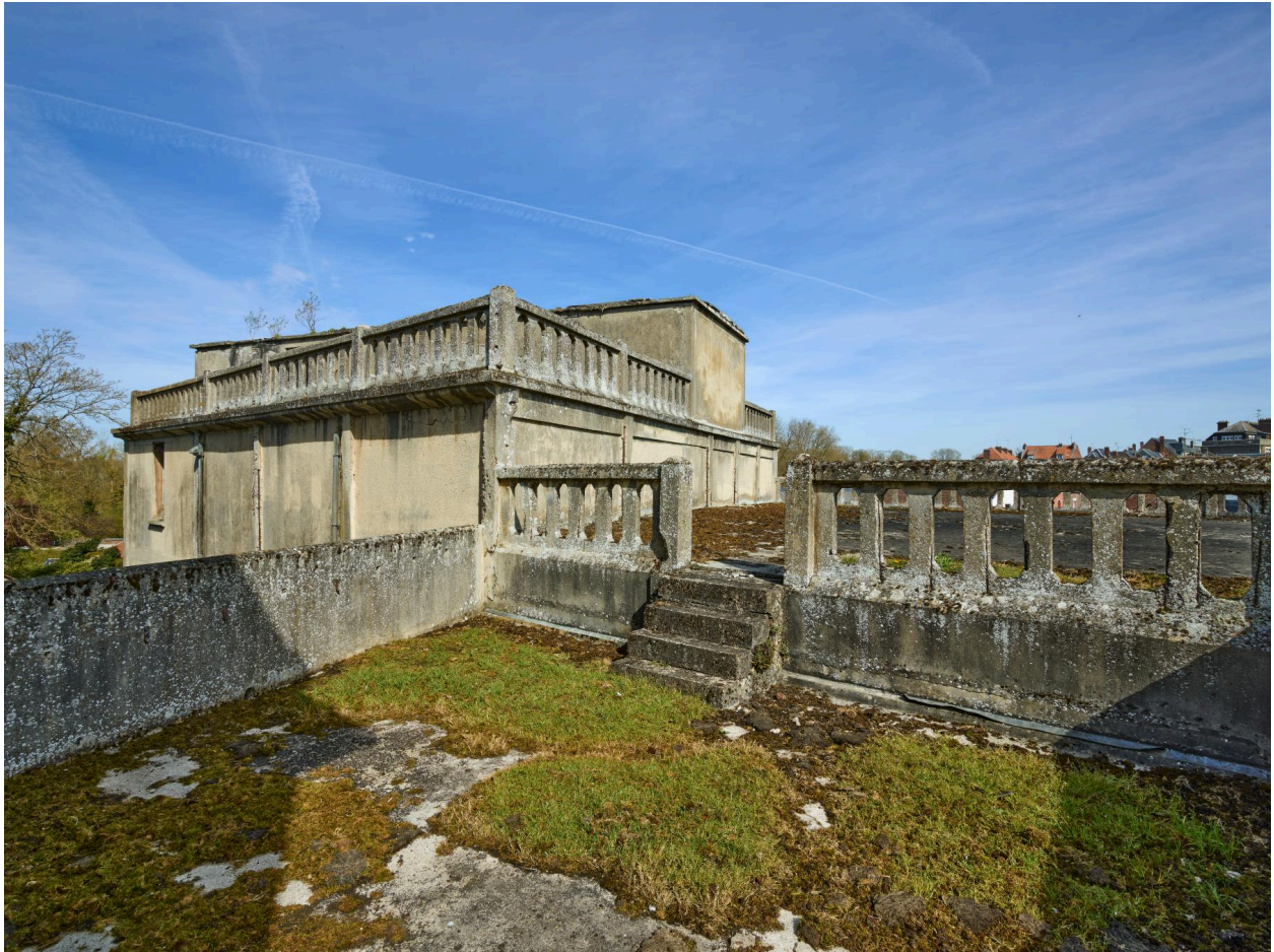
Les différents niveaux des toits-terrasses de la minoterie et l'escalier de liaison.
