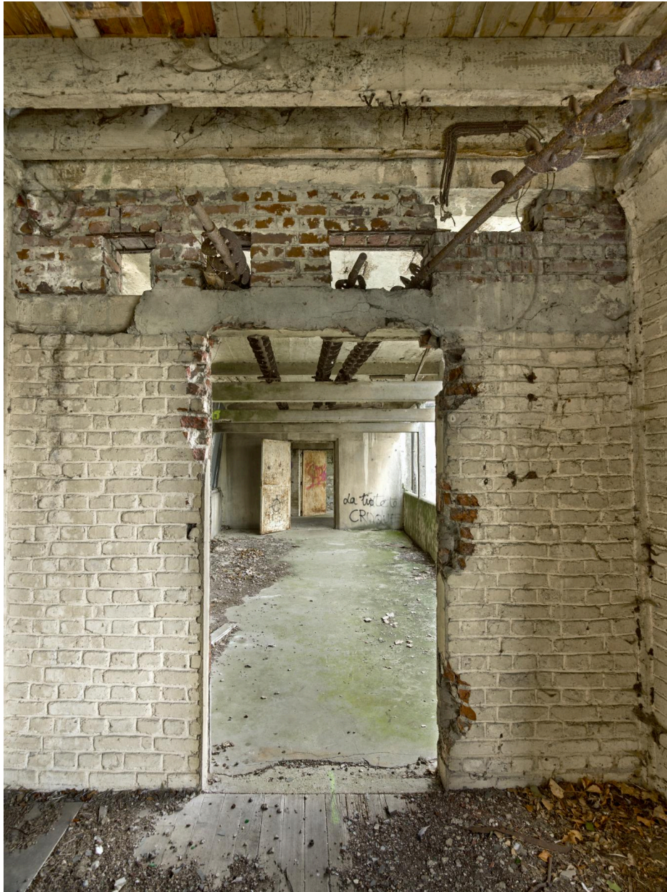
Ouverture vers la galerie surplombant la coulerie centrale.
