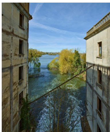
La coulerie depuis la passerelle et la vue sur la Somme, en aval. Phot. Thierry Lefébure IVR32_20228000072NUCA
