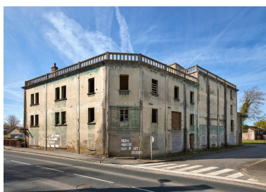
Vue d'ensemble nord-est de la minoterie donnant sur la rue Marin. Phot. Thierry Lefébure IVR32_20228000058NUCA
