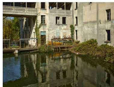
Vannage de la petite roue hydraulique. Phot. Thierry Lefébure IVR32_20228000054NUCA
