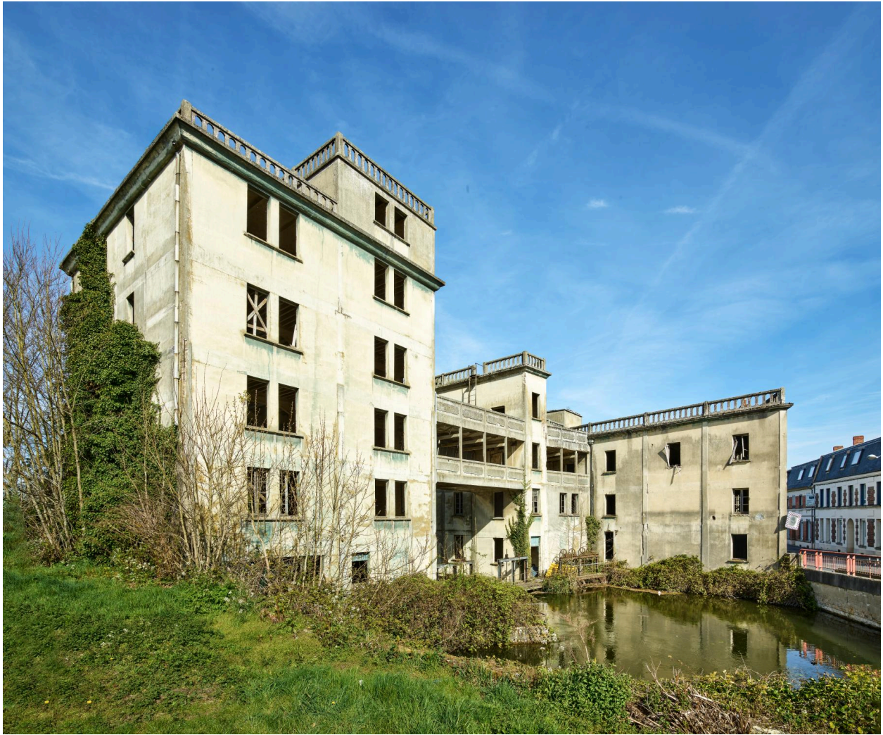
Vue générale sud-est de la minoterie.
