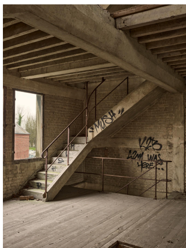
Escalier en béton de la salle des sasseurs. Phot. Thierry Lefébure IVR32_20228000090NUCA
