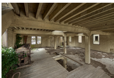
Intérieur du deuxième étage de la minoterie. Phot. Thierry Lefébure IVR32_20228000081NUCA
