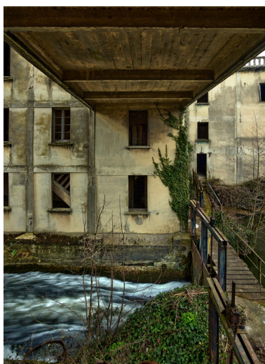
Détail de la coulerie et du tablier de la passerelle reliant les deux parties de la minoterie. Phot. Thierry Lefébure IVR32_20228000069NUCA
