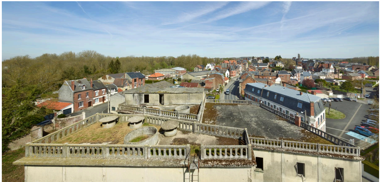
Terrasse des silos et magasins.
