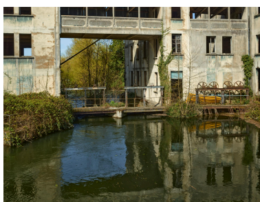
Vannage ouvrier de l'ancienne petite roue hydraulique, remplacée par une turbine. Phot. Thierry Lefébure IVR32_20228000055NUCA
