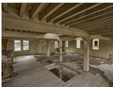
Ancienne salle des plansichters dont l'emplacement est marqué par les trous rectangulaires du plancher. Phot. Thierry Lefébure IVR32_20228000086NUCA
