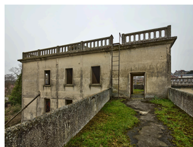
Passage supérieur vers les terrasses de la minoterie. Phot. Thierry Lefébure IVR32_20228000068NUCA
