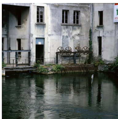
Vannage ouvrier de l'ancienne grande roue hydraulique et du musoir en éperon du côté sud. Phot. Thierry Lefébure IVR22_20018000291XA
