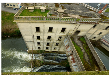
La passerelle reliant les deux corps de bâtiments de la minoterie, vue de dessus. Phot. Thierry Lefébure IVR32_202280005172NUCA
