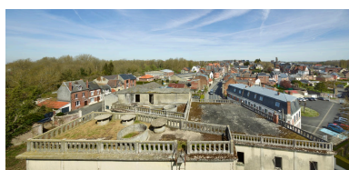
Terrasse des silos et magasins. Phot. Thierry Lefébure IVR32_20228000076NUCA
