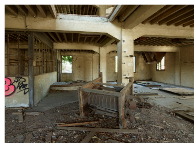
Intérieur du deuxième étage de la minoterie. Phot. Thierry Lefébure IVR32_20228000102NUCA
