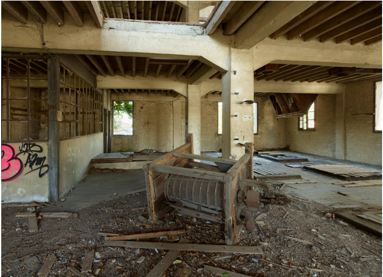
Intérieur du deuxième étage de la minoterie.
