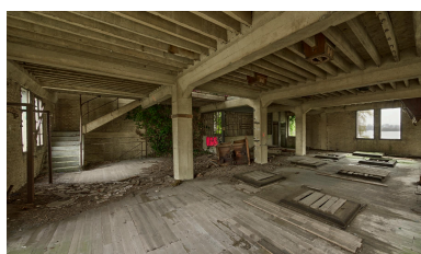
Intérieur du deuxième étage de la minoterie. Phot. Thierry Lefébure IVR32_20228000095NUCA
