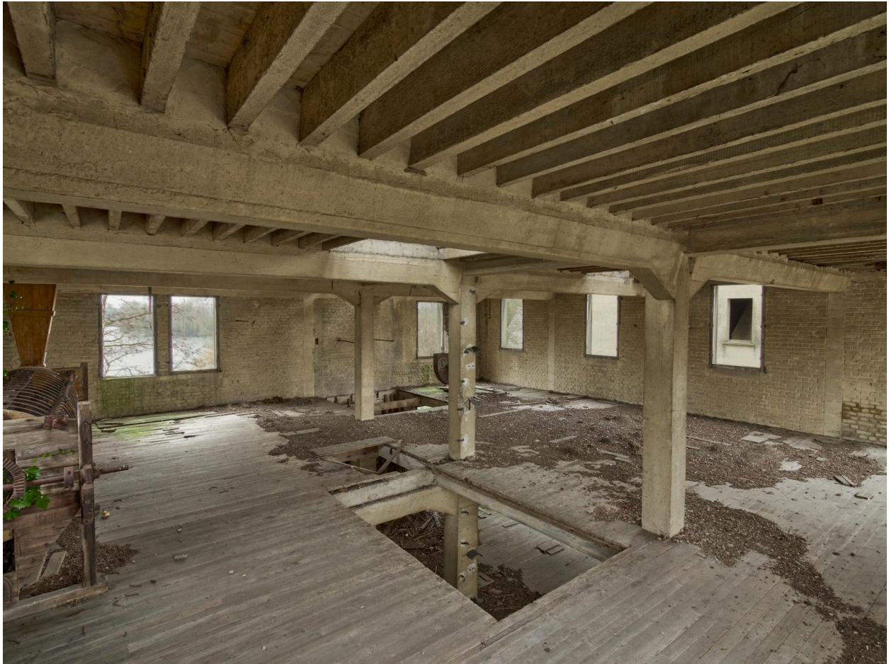
Ancienne salle des plansichters dont l'emplacement est marqué par les trous rectangulaires du plancher.
