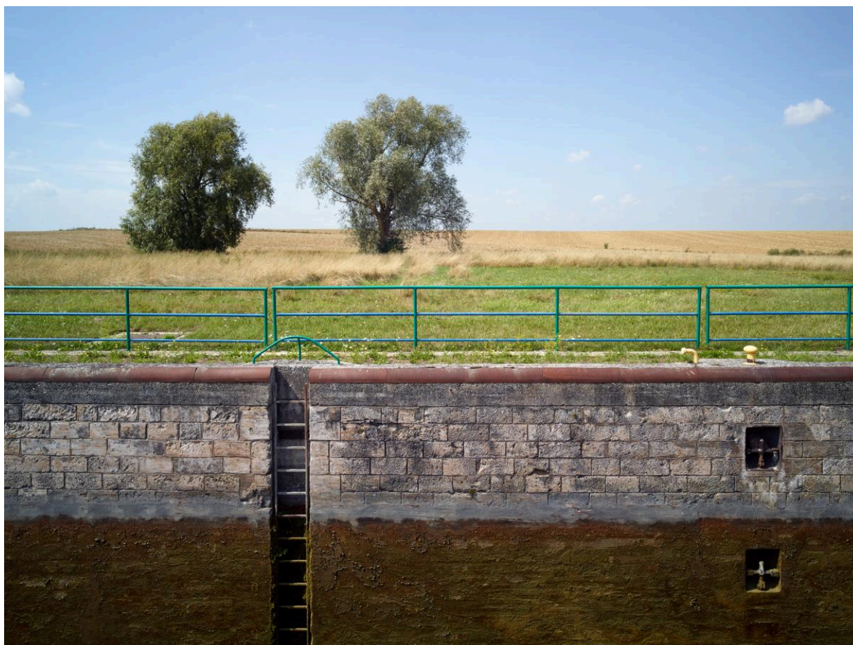
Site d'écluse n°7 de Graincourt-lès-Havrincourt.
