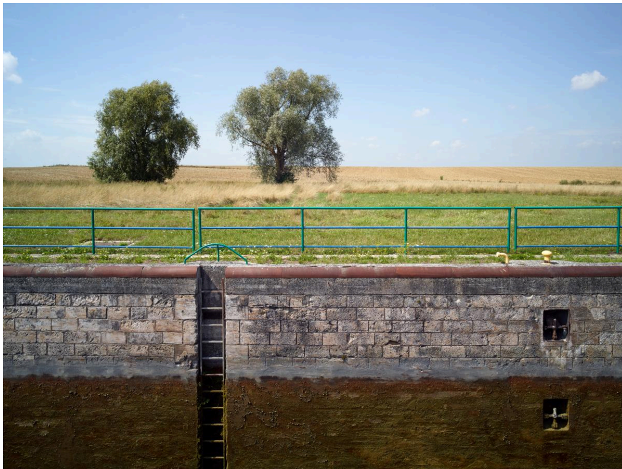
Site d'écluse n°7 de Graincourt-lès-Havrincourt.
