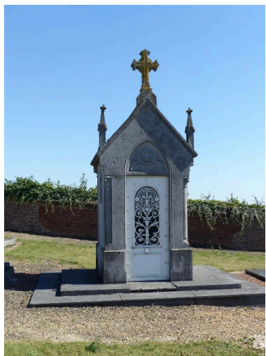
Tombeau (chapelle) de la famille Lejeune-Détenne, Rembaux et Cie (Aulnoye- Nord), limite 19e siècle 20e siècle. Phot. Isabelle Barbedor IVR32_20168006137NUCA
