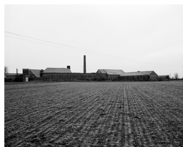
La briqueterie-tuilerie, rue H. Fivet. Phot. Philippe Dapvril IVR31_20045901092X
