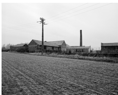
La briqueterie-tuilerie, rue H. Fivet. Phot. Philippe Dapvril IVR31_20045901104X
