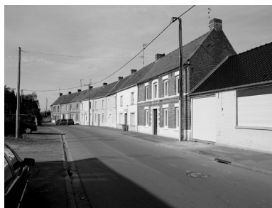
Alignement de maisons, rue de l'ancienne poste. Phot. Philippe Dapvril IVR31_20045900460X
