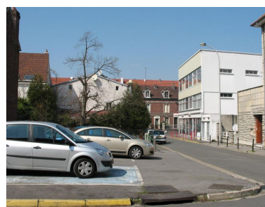
Parcelle de l'usine entre la rue Dolet et Henri-Pauquet. Phot. Clarisse Lorieux IVR22_20076005140NUCA
