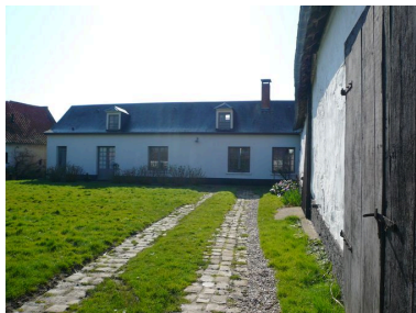
Vue du logis. Phot. Inès Guérin IVR22_20078005490NUCA
