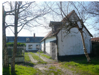
Vue de la grange. Phot. Inès Guérin IVR22_20078005491NUCA
