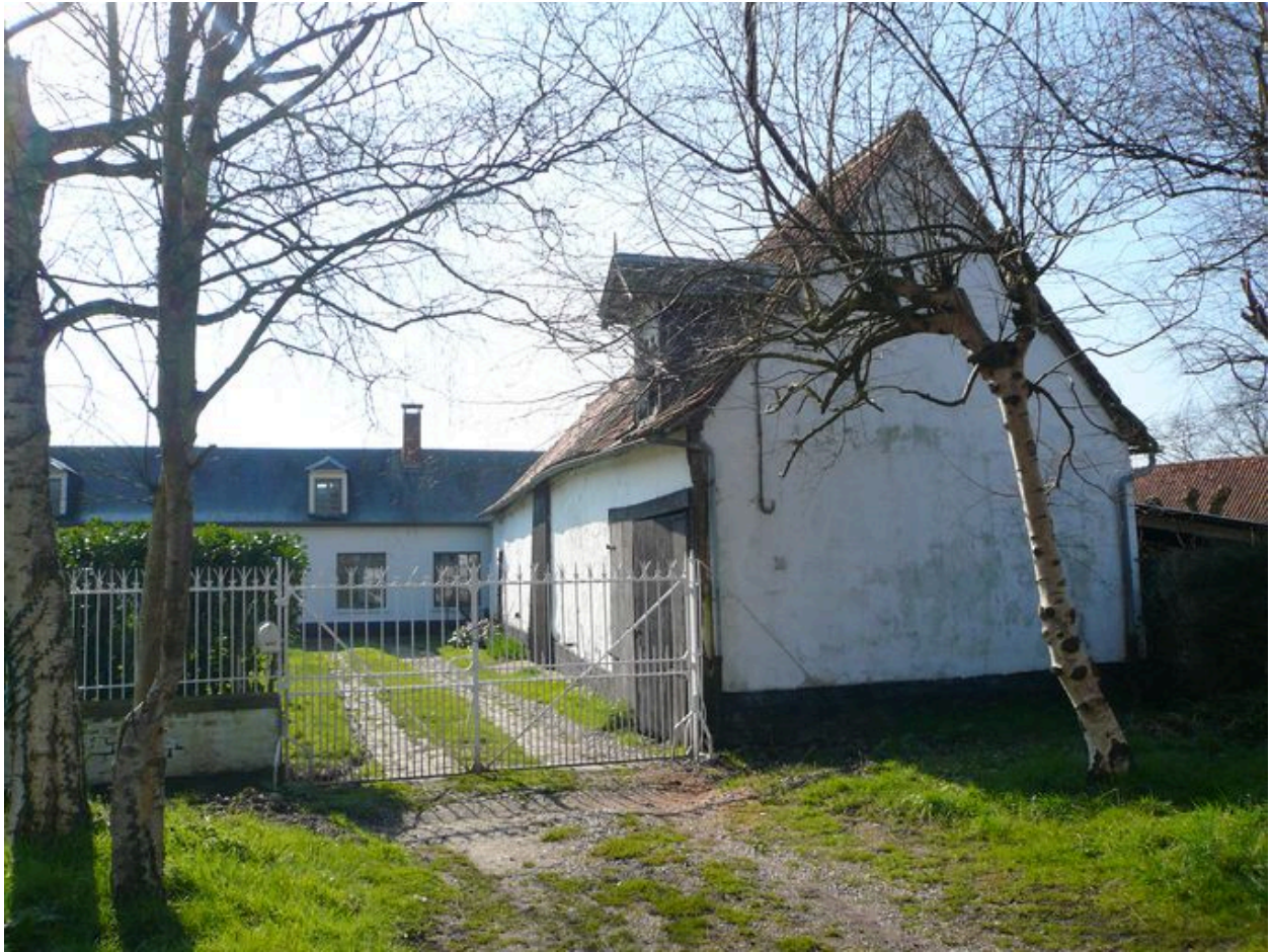
Vue de la grange.
