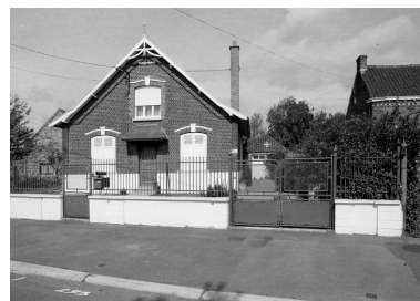
Vue générale de la maison située 212, rue de la Résistance. Phot. Philippe Dapvril IVR31_20045900455X
