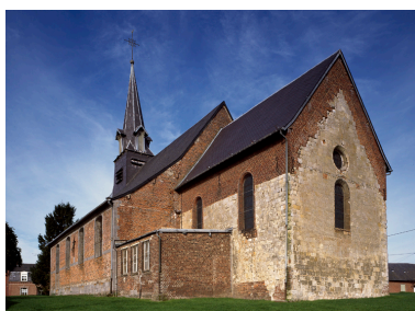
Vue générale, depuis l'est. Phot. Thierry Lefébure IVR22_19950202890VA
