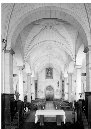
Vue intérieure depuis le chœur. Phot. Thierry Lefébure IVR22_19950202853V
