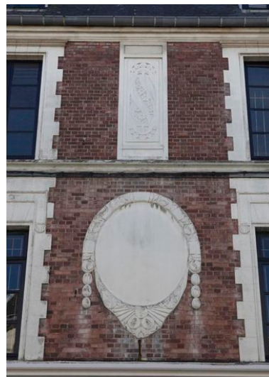
Ensemble composé d'un cartouche et d'un médaillon ornés de décors floraux et de motifs géométriques et positionnés sur le trumeau central de la façade. Phot. Pierre Thibaut IVR31_20096200192NUCA
