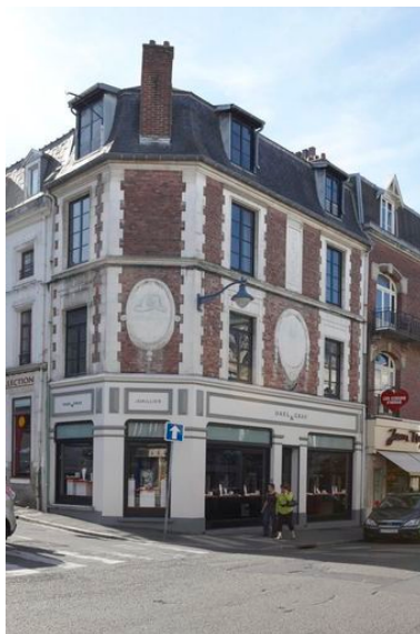
Vue générale. Phot. Pierre Thibaut IVR31_20086200163NUCA
