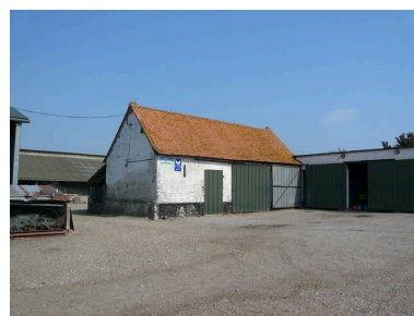
Vue de l'écurie à l'est de la cour. Phot. Inès Guérin IVR22_20078005884NUCA
