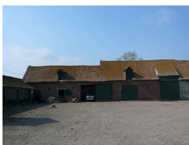
Vue de la grange et des étables au nord. Phot. Inès Guérin IVR22_20078005886NUCA
