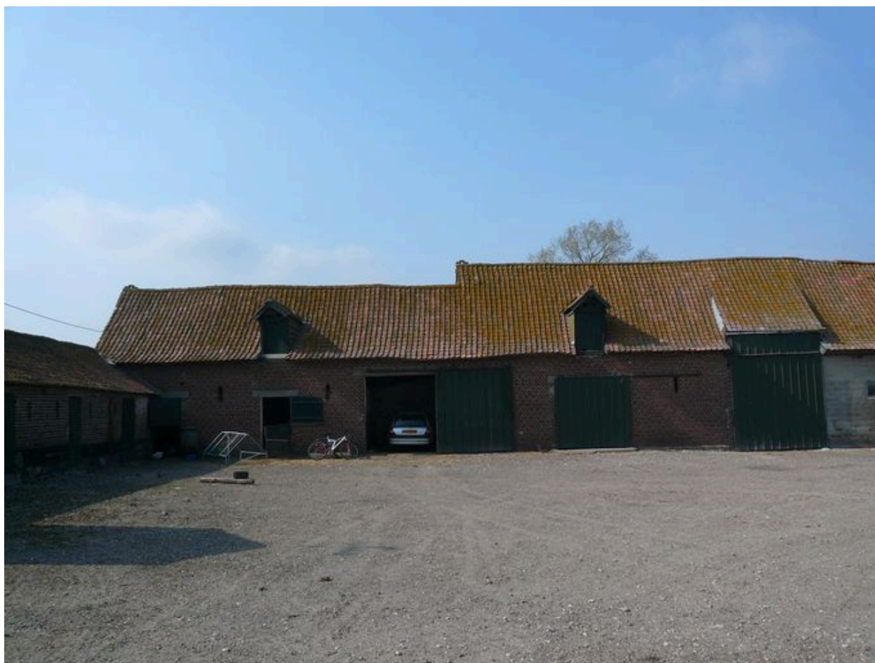
Vue de la grange et des étables au nord.
