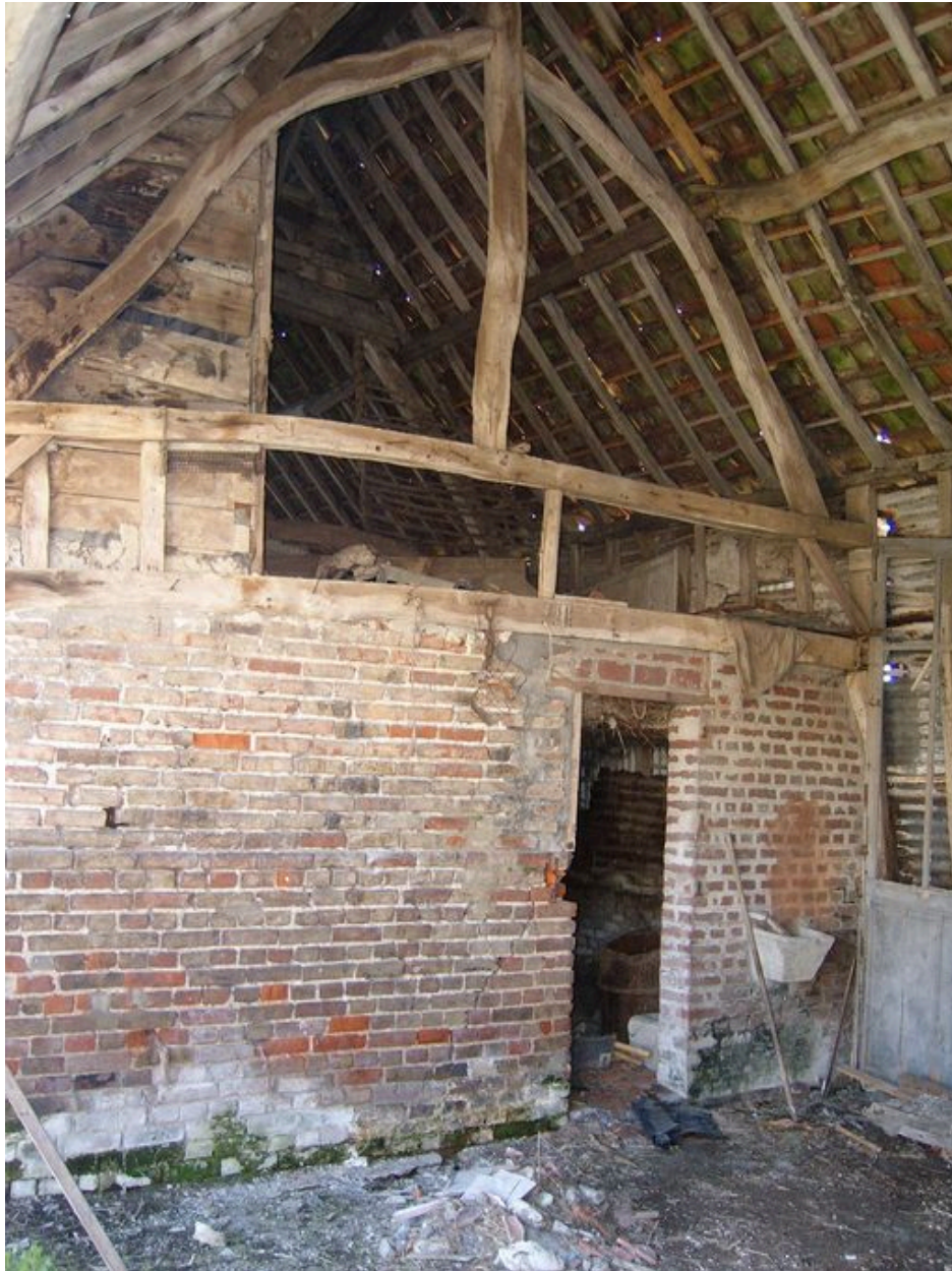
Vue de la charpente de la grange.
