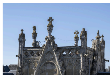
Sommet du chœur : contreforts, gâble, garde-corps. Phot. Pierre Thibaut IVR32_20265900653NUCA
