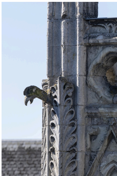
Détail d'une gargouille en forme de rapace située sur les contreforts. Phot. Pierre Thibaut IVR32_20265900651NUCA
