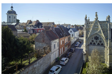
Vue cavalière de la façade est du chevet de la chapelle depuis la toiture de l'hospice. Le beffroi est visible à l'arrière-plan. Phot. Pierre Thibaut IVR32_20265900646NUCA
