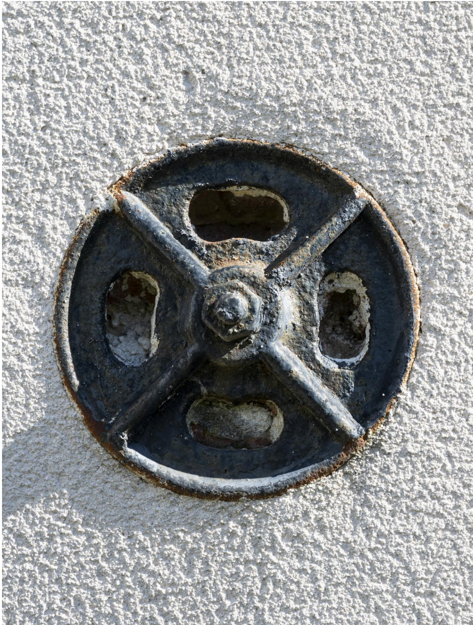
Détail d'un fer datant de la fin du XIXe siècle, lors des travaux de reprise des murs de la chapelle.
