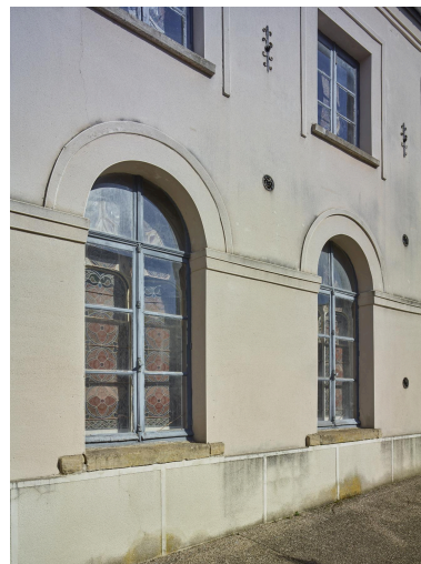
Vue de détail des baies et du positionnement des fers d'ancrage sur la façade ouest. Phot. Pierre Thibaut IVR32_20265900689NUCA
