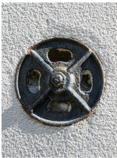
Détail d'un fer datant de la fin du XIXe siècle, lors des travaux de reprise des murs de la chapelle. Phot. Pierre Thibaut IVR32_20265900675NUCA
