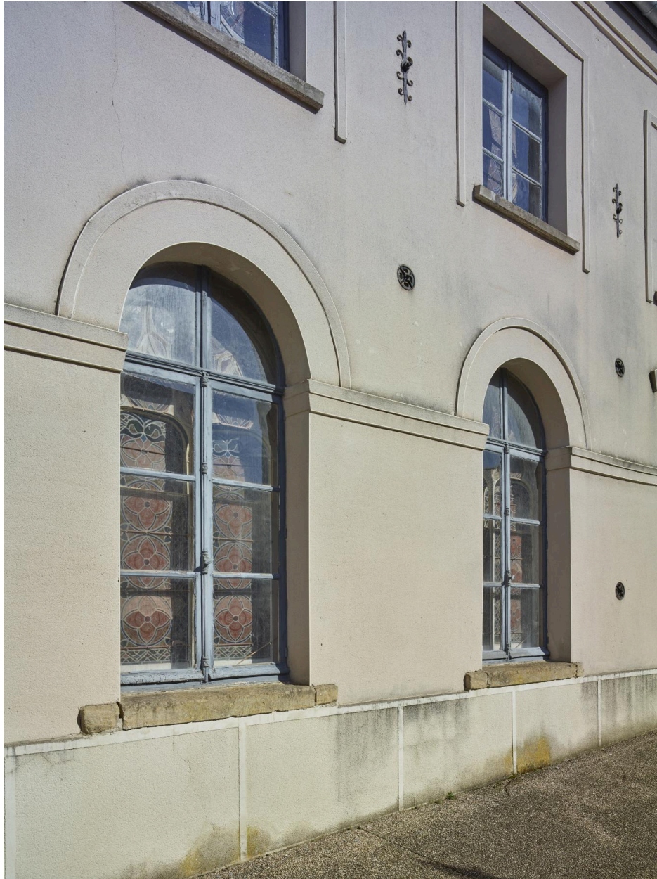
Vue de détail des baies et du positionnement des fers d'ancrage sur la façade ouest.
