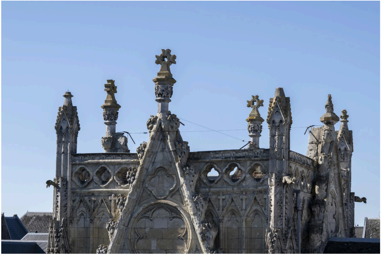
Sommet du chœur : contreforts, gâble, garde-corps.
