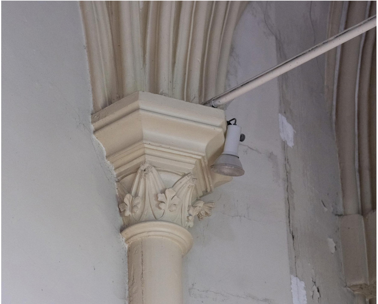
Détail d'un chapiteau et de l'abaque recevant les nervures de la voûte.
